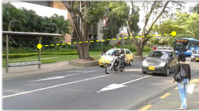
Fig. 3-32. Cobertizos no coinciden con los puntos de parada MIO. CL29/6AN.
