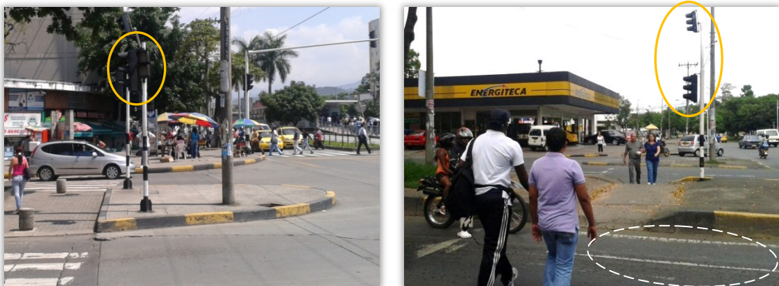
Fig. 3-20. Semáforos peatonales no funcionan o hacen falta. Están borradas las ‘cebras’. Et. Tequendama (izq.) - CL6/44 (der.)
