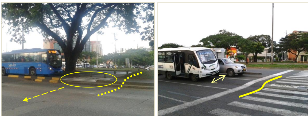
Fig. 3-18. Desniveles / obstáculos en la vía. 'Cebraz' pintadas sólo hasta la mitad de un cruce. CL5/70 (izq.) CL6/39 (der.)
