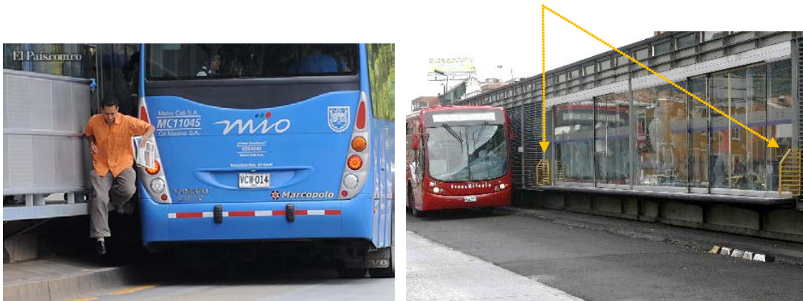
Fig. 3-23. Hacen falta barreras físicas en las estaciones MIO (izq.), las que se encuentran por ejemplo en las estaciones Transmilenio en Bogotá, Colombia (der.)
