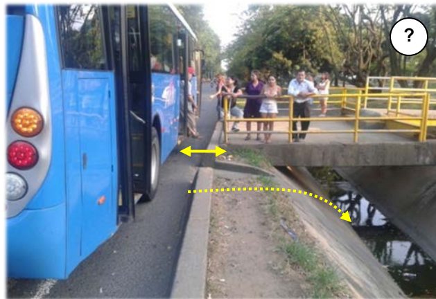
Fig. 3-31. PED no corresponden a las condiciones básicas de acceso y seguridad. CL25/83.
