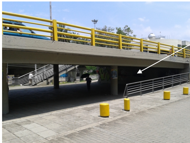
Fig. 3-7. Espacio debajo de un puente sirve para instalar kioscos de venta. Et. Santa Librada.
