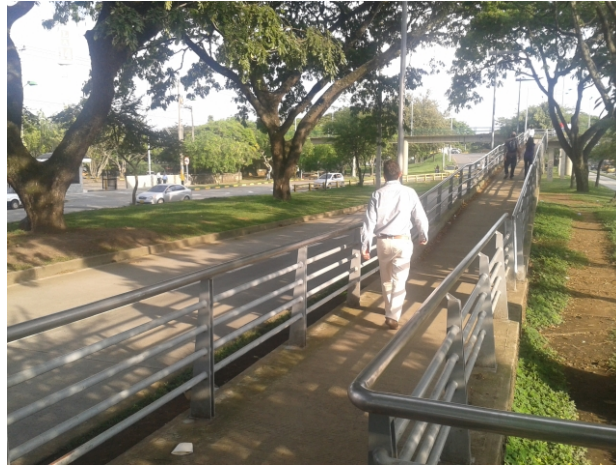
Fig. 3-14. Puentes aumentan significativamente la distancia de acceso. Et. Caldas.
