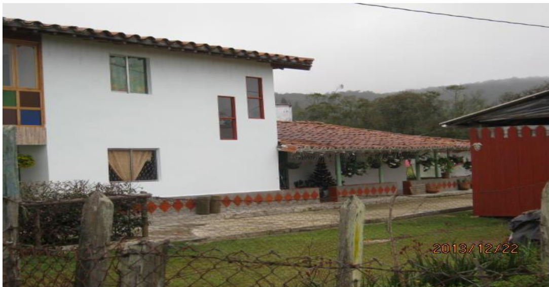
Ilustración 4- 7 . Construcción de una nueva vivienda campestre sobre un espacio de vivienda tradicional, Vereda El Plan
