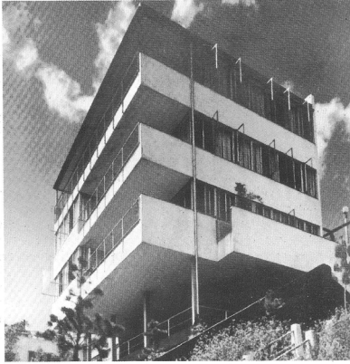
Vista desde el sudoeste Terraza de la planta segunda
