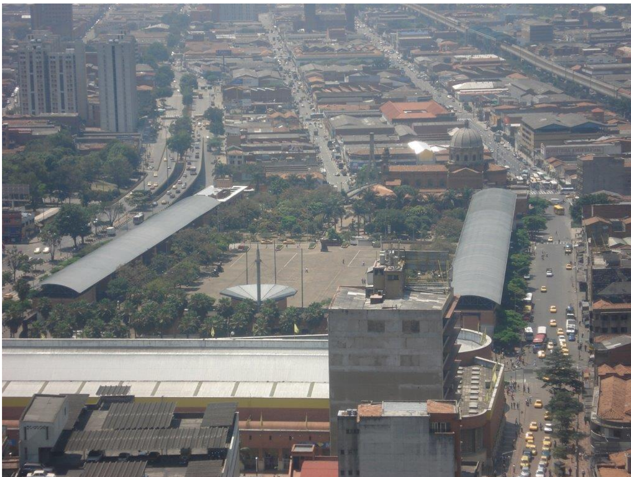
Figura 5 Vista Panorámica de Norte a Sur del parque de San Antonio por: Carlos Córdoba
