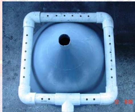
Figura 4.4.2. Esquema de instalación real de las flautas recolectoras del efluente para cada reactor.
