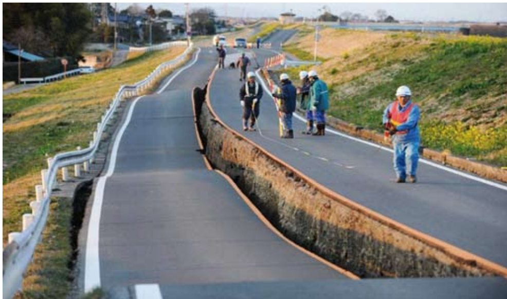
Figura 3. Evidencia de ondulaciones y desplazamientos métricos en el suelo durante el sismo de Tohoku. Foto: G-News
