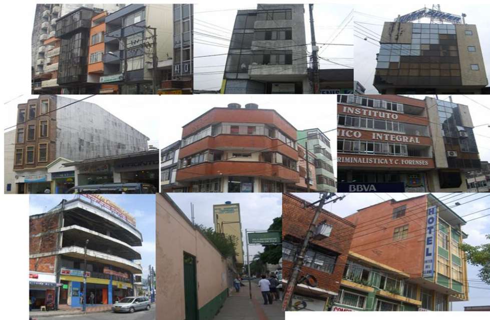
Figura 13. Fotografías que muestran algunos ejemplos de las malas condiciones estructurales y de sismoresistencia en algunos de los edificios de la ciudad. Arriba, edificaciones residenciales de estrato socioeconómico medio con parámetros técnicos irregulares y la no contemplación de la normatividad de sismoresistencia.
