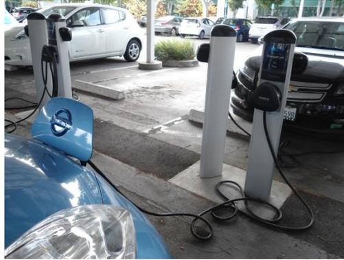
**Gráfica 4-8:** Instalación del EVSE con pila exterior. \*Esta imagen es propiedad del autor
