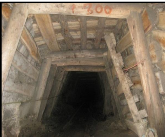
Imagen 5. Inclinado de mina (mina Campohermoso 2). Fuente: Autor
