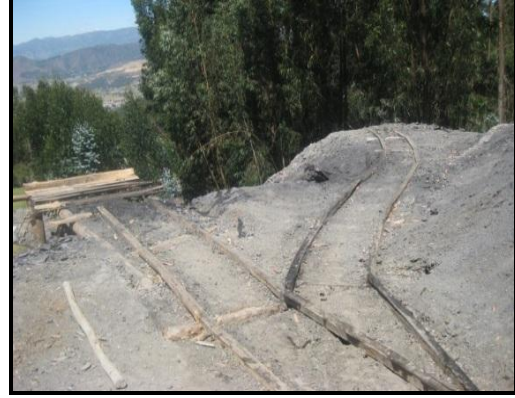
Imagen 8. Cruce de vías en para estéril y mineral de carbón (mina las Motuas). Fuente: Autor
