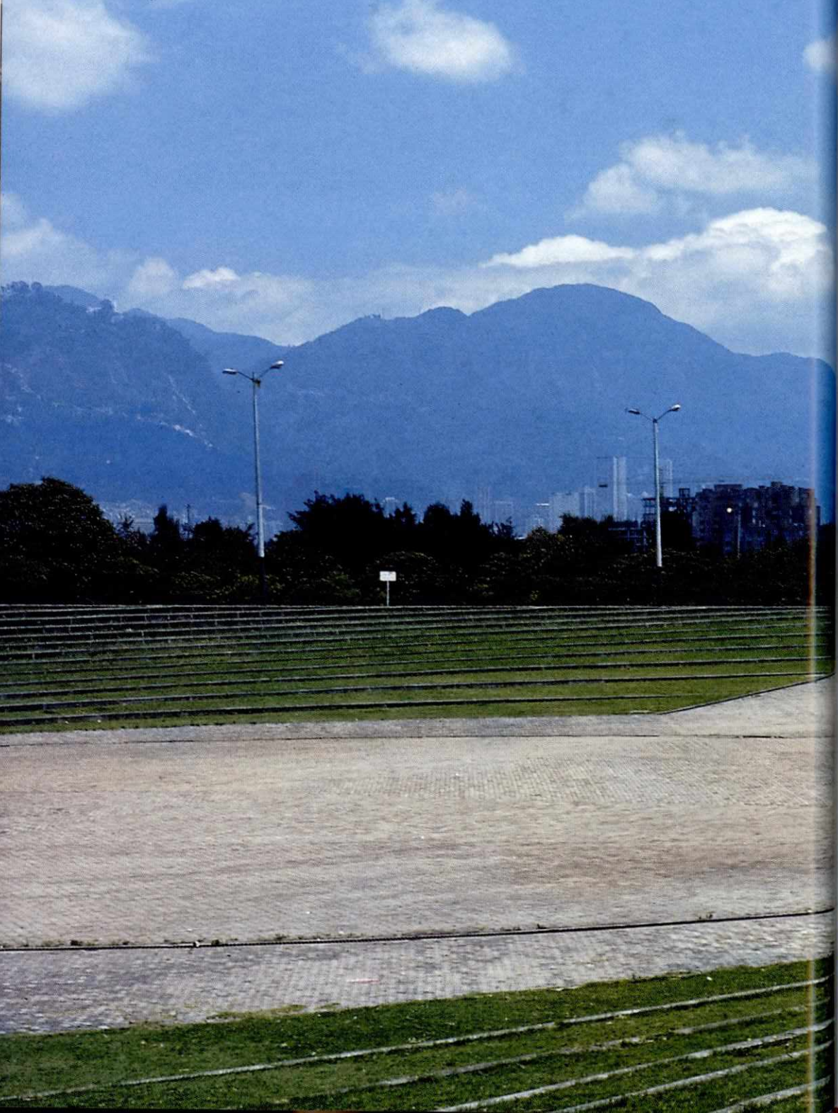
Foto 6. En la Plaza Ceremonial, las graderías, a cielo abierto, son el resultado de pequeños movimientos de tierra. Fotografía: Beatriz García Moreno.
