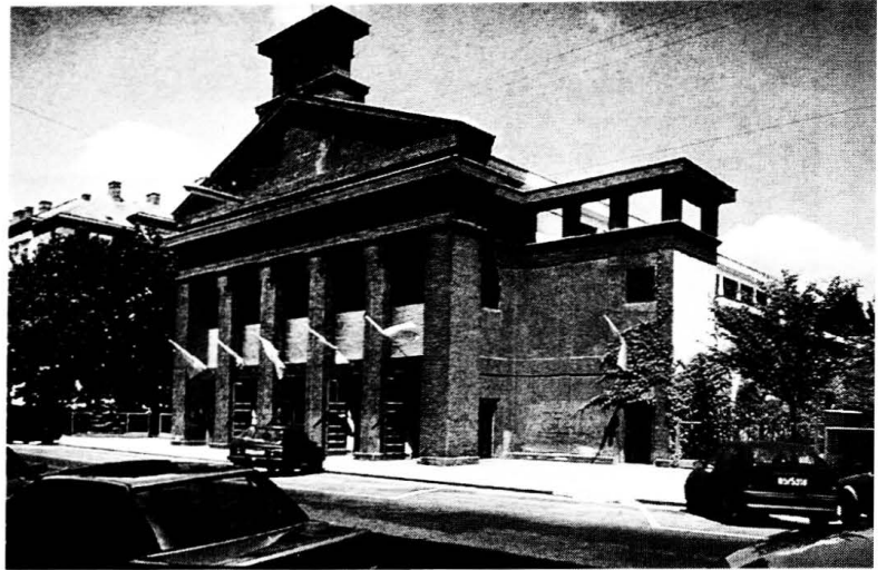
3. Iglesia del Espíritu Santo, fachada
