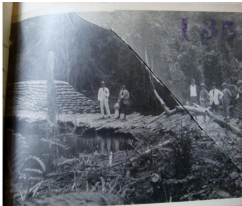
Figura 8. Parte del dique y del puente sobre el río Aracataca en el punto denominado San Joaquín. Inspección Ocular adelantada por la Comisión de Baldíos en julio de 1924.
