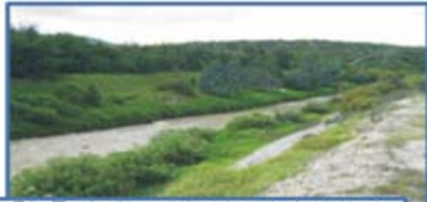
Río Tunjuelo en el sector de la cantera La Fiscalá. Se aprecia el reforzamiento de los diques que separan el río de la cantera
