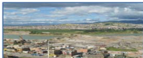
Sector de canteras de explotación con minería en la ronda del río Tunjuelo, las fosas presentan una profundidad inferior al lecho del río
