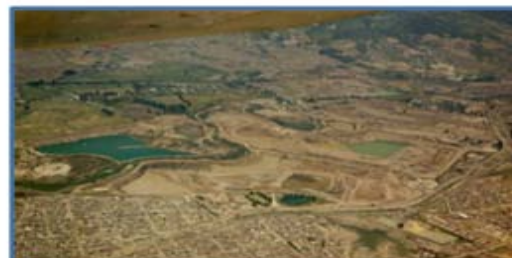
En la parte inferior se pueden apreciar los barrios de Meissen, México y Lucero Bajo, canteras ubicadas en el PMI de Tunjuelo. Fuente: Archivo fotográfico de Central de Mezclas 1996
