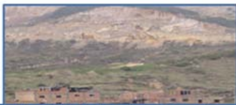
Barrio Juan Pablo II rellenos de escombros, basuras y taludes de canteras, disposición de desechos industriales y urbanísticos: plásticos, demoliciones, cauchos, telas, papeles, susceptible a PRM.
