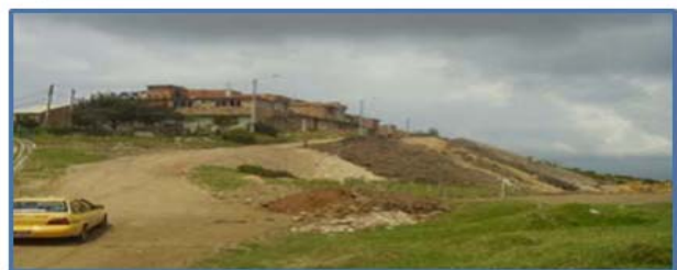
Medidas de control del cauce del Río Tunjuelo. Barrio Casalinda urbanización de origen ilegal sobre rellenos antrópicos, debe ser objeto de monitoreo por problemas de cimentación e incumplimiento de la norma sismo-resistente NSR-98
