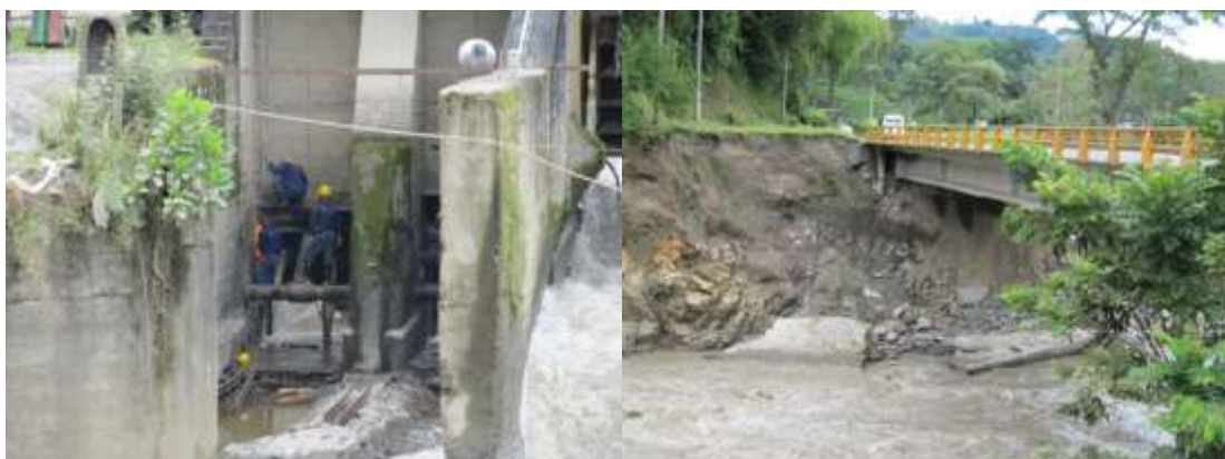
Fotografía 10.8. 2.07.2011, operarios arreglando compuertas en bocatoma Montevideo. Foto: F. González.
