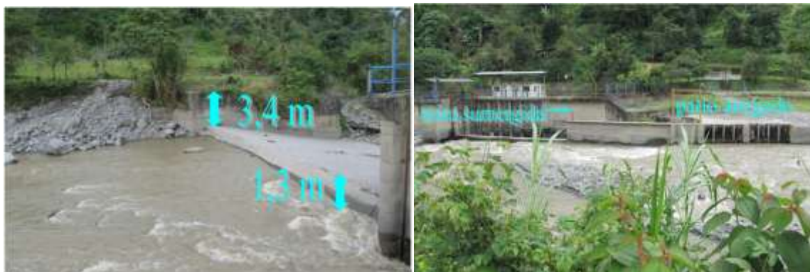
Fotografía 10.2. Nivel alcanzado por la creciente en el vertedero y altura de la cresta Foto: F. González.
