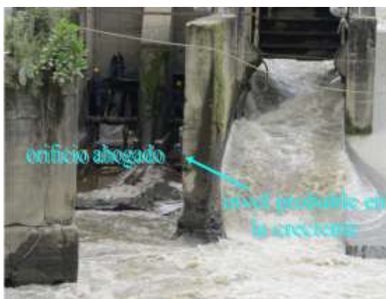
Fotografía 10.6. Compuertas pequeñas funcionando como orificio ahogado en la creciente. Foto: F. González.
