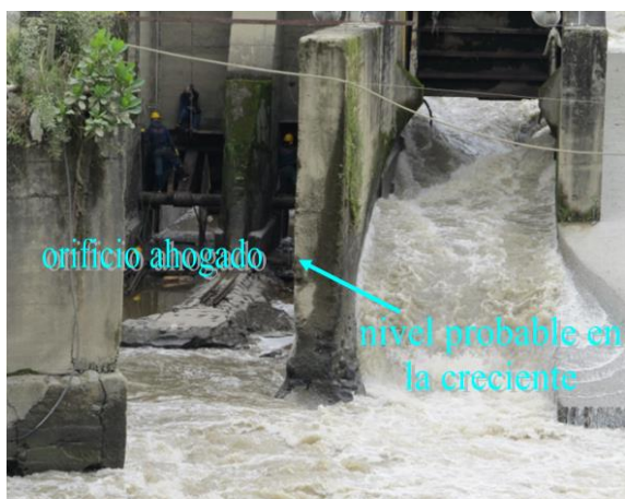
Fotografía 10.6. Compuertas pequeñas funcionando como orificio ahogado en la creciente. Foto: F. González.
