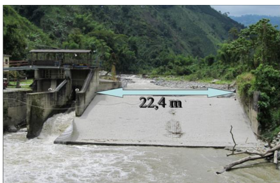
Fotografía 10.4. Vertedero de la bocatoma de Montevideo. Foto: F. González.
