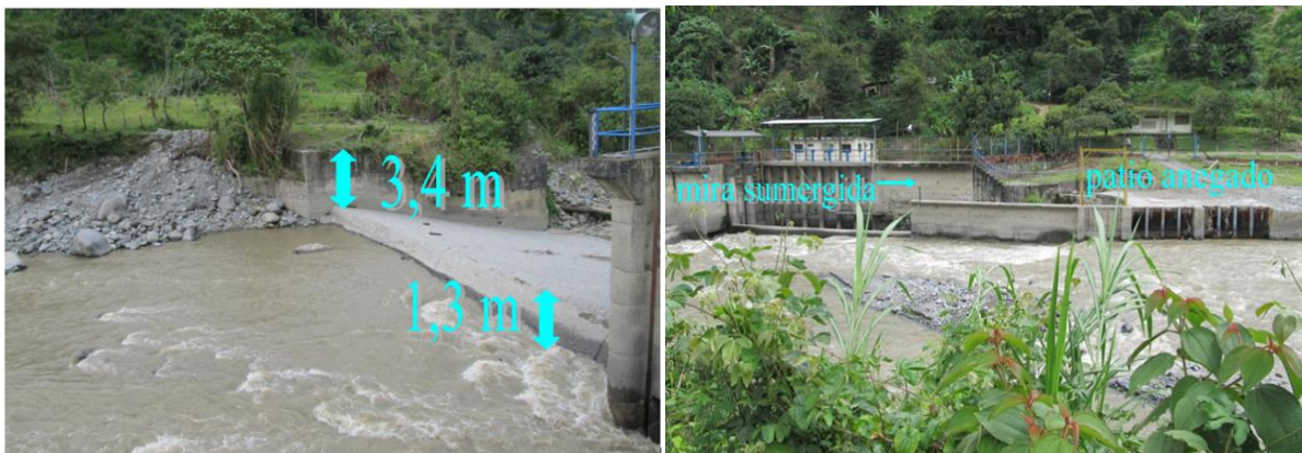
Fotografía 10.2. Nivel alcanzado por la creciete en el vertedero y altura de la cresta Foto: F. González.
