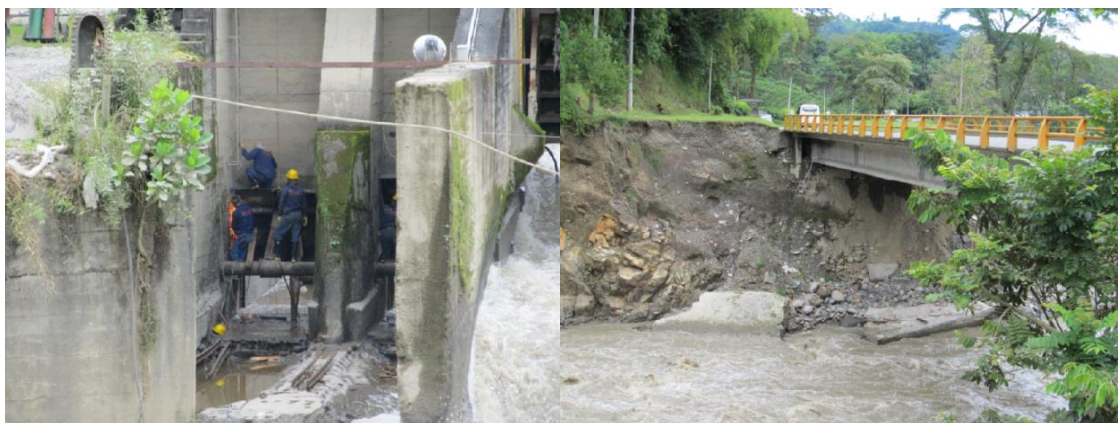
Fotografía 10.8. 2.07.2011, operarios arreglando compuertas en bocatoma Montevideo. Foto: F. González.
