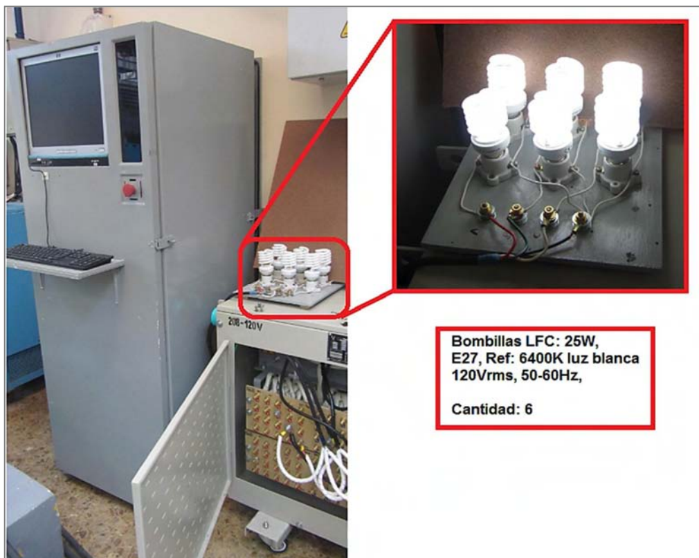
Figura 5-23: Montaje de prueba con cargas LFC.
