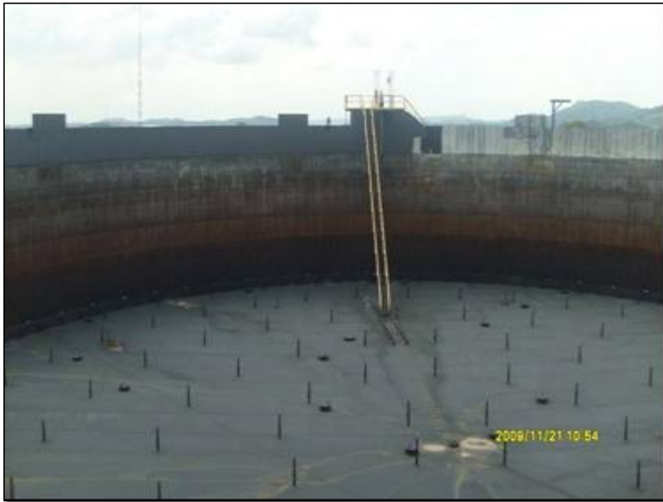
Fotografía A1: Tanque de Almacenamiento en Mantenimiento.
