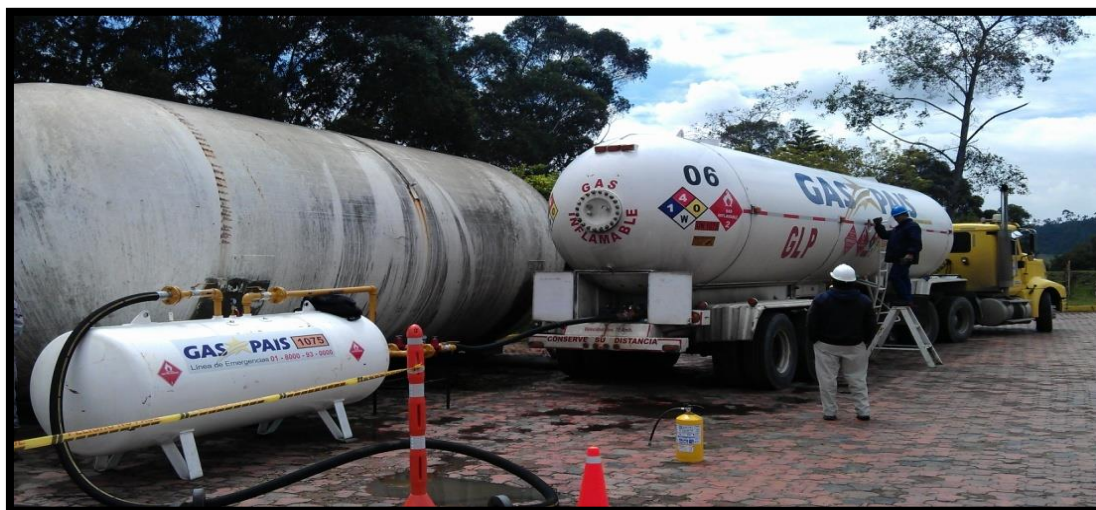
Figura 22: Conexión de Cisterna de GLP con tanque pulmón homogenizador de presión y verificación de rotogage de cisterna de almacenamiento de GLP Fuente: Ecopetrol – Esei
