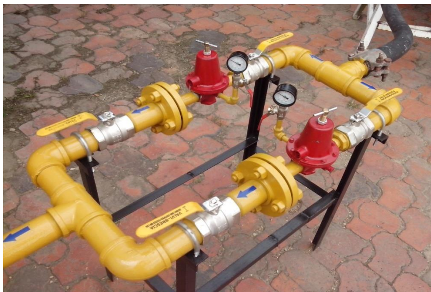
Figura 23: Regulador de presión en paralelo de GLP Fuente: Ecopetrol - Esei
