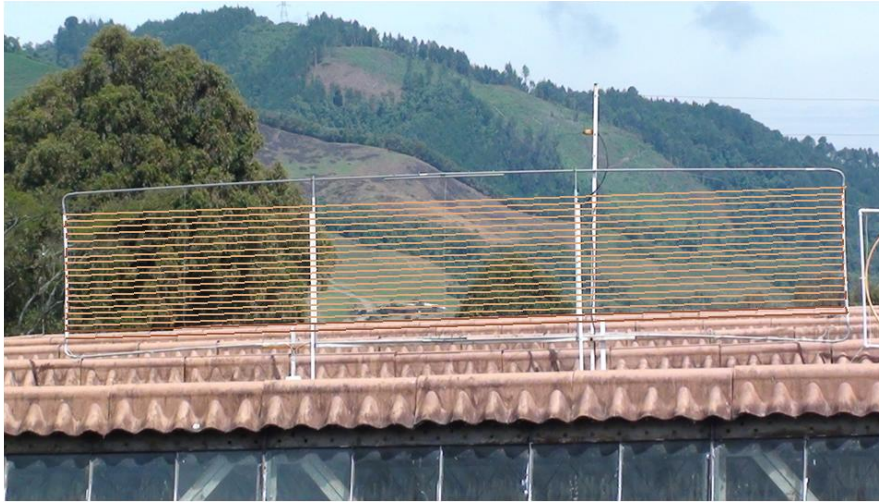
Fig. 7.29: Foto Antena Parrilla implementada e instalada sobre el techo.
