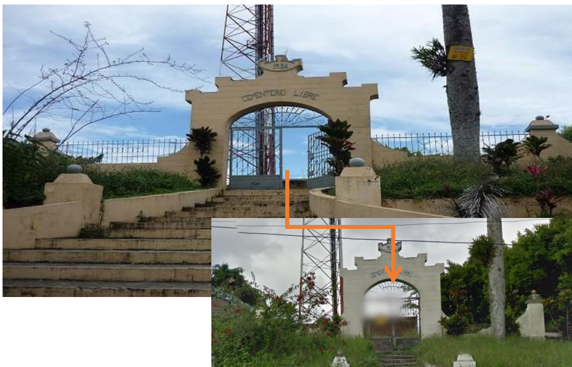
Figuras 4.130, 4.131 y 1.132. Estado actual de Cementerios Libres de Montenegro y Circasia
