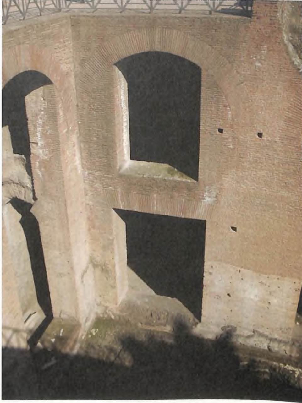
Figura 5. Arco rebajado en la arquitectura doméstica romana (Domus Augustana, siglo I dC). Fotografía: Jorge Galindo.
