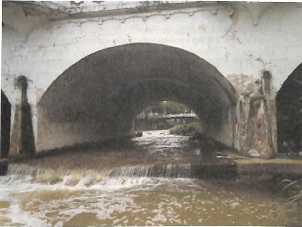
Figura 73. Interior de las bóvedas del puente Ortiz en donde se aprecia la estructura original de ladrillo en medio de sendas estructuras de hormigón simple.
