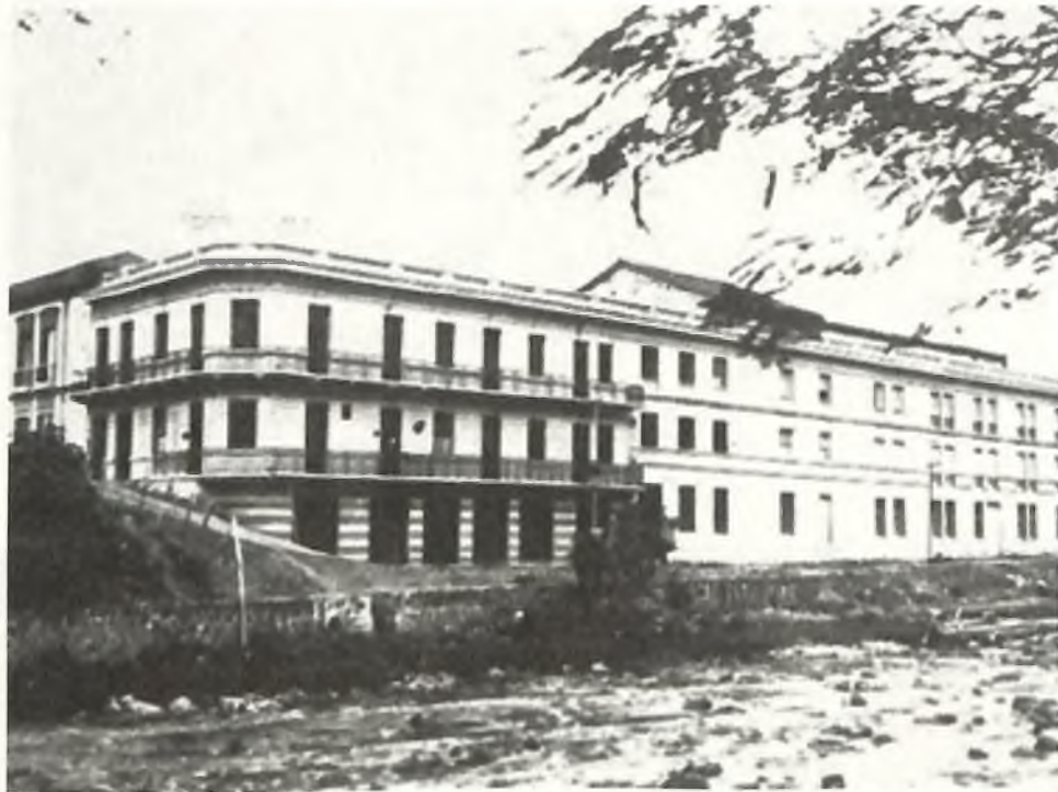
Figura 61. Edificios de nueva planta construidos mirando hacia el río Cali. Nótese el muro de contención de poca altura, la fuerte pendiente de la calle 11 y la calle angosta que se forma entre el muro de contención y la línea de paramento.
