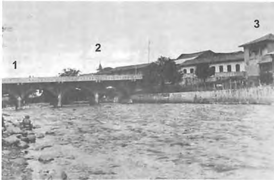
Figura 60. A la izquierda el puente Ortiz con las barandas y las vigas de ferrocemento dispuestas en 1918 (1); atrás, la primigenia capilla de La Ermita (2) y la casa Bosh (3) (ca. 1920).
