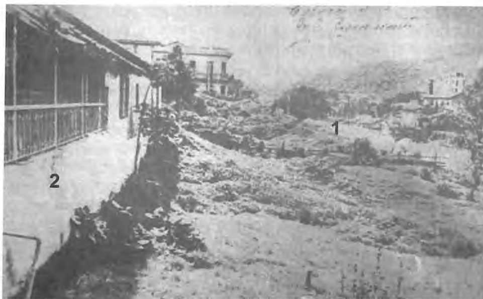
Figura 59. Orilla sur (derecha) del río Cali hacia 1930 (1); en primer plano (izquierda), la casa de Matilde Bosch (2).
