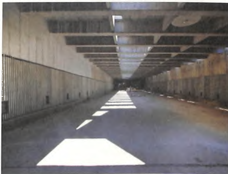
Figura 83. Vista del interior del box culvert bajo la avenida Colombia.
