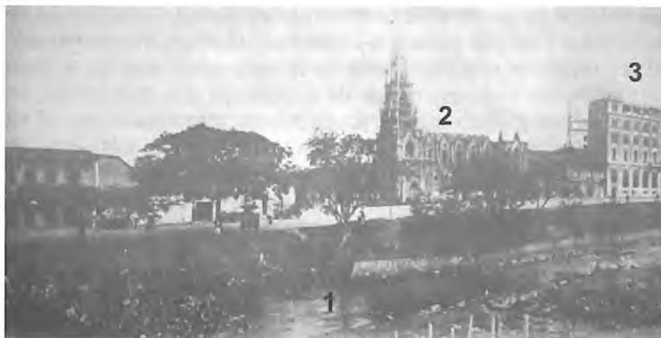
Figura 57. Muro de contención frente a la avenida Uribe Uribe (1); al fondo la iglesia de La Ermita en construcción (2) y en el extremo derecho, el Hotel Alférez Real (3), también en construcción (ca. 1928).
