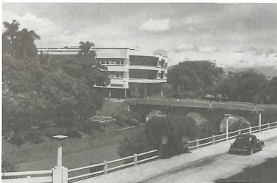
Figura 74. El puente Ortiz sobre el río Cali antes de la intervención de 1945 y al fondo, el edificio Gutiérrez Vélez. Nótese que la avenida Colombia ya está en uso.
