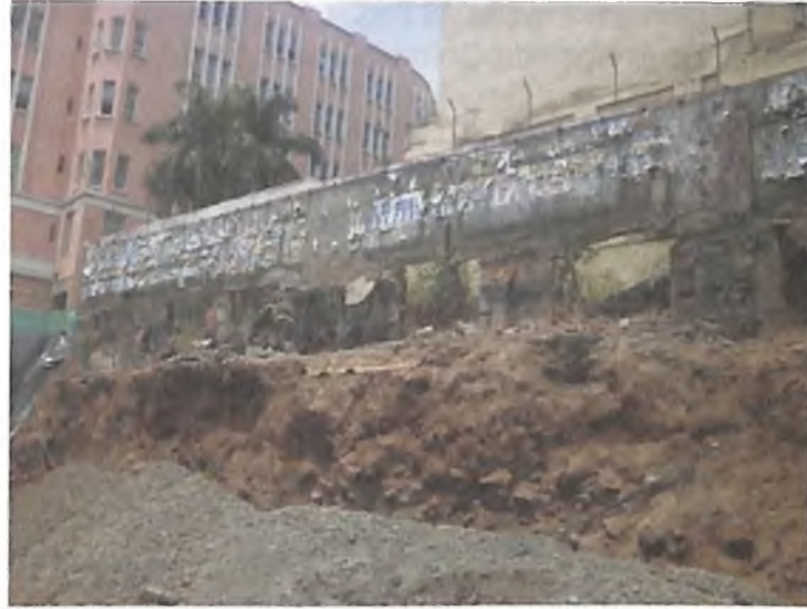
Figura 62. Vestigios del mismo edificio apreciables en 2011 cuando se ha demolido el andén de la Av. Colombia. Los vanos del primer piso estaban enterrados en su totalidad.
