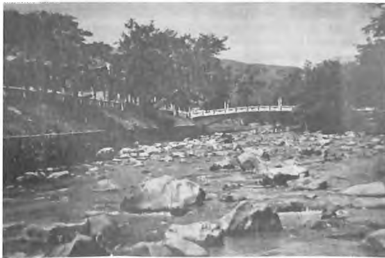
Figura 71. Puente de Los Próceres o puente de El Peñón; nótese la cuidada orilla izquierda del río colindante con la avenida Colombia.
