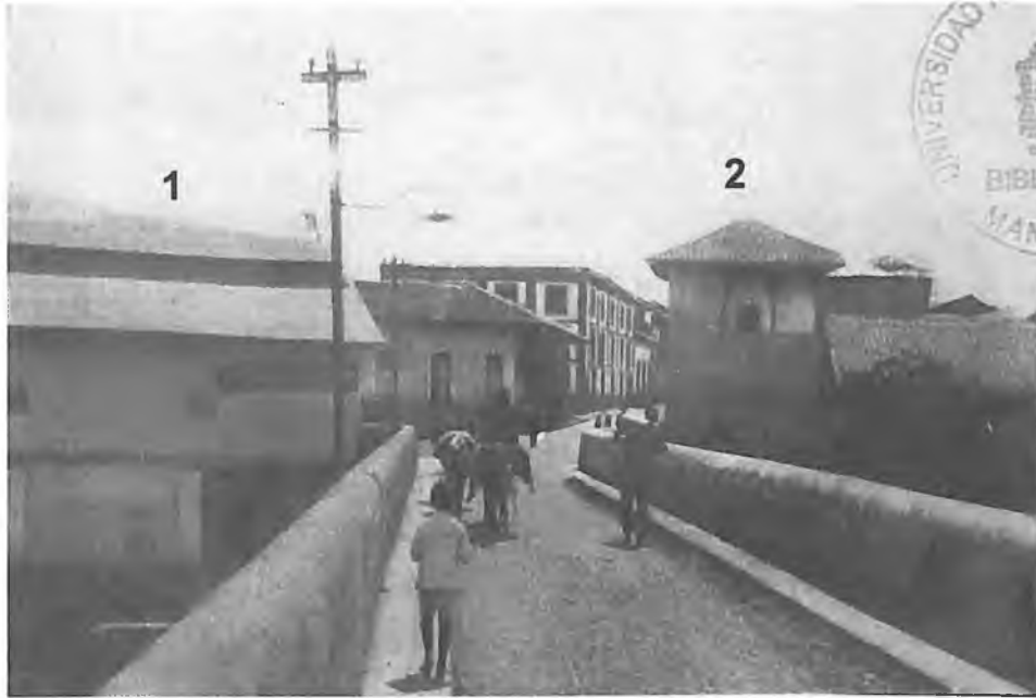
Figura 51. Vista de la calle 12 desde el puente de calicanto (sentido norte – sur). A la izquierda, casa de los señores Giraldo y Garcés (1); a la derecha, casa Bosch (2).
