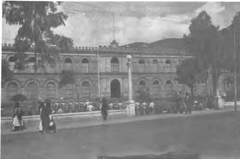
Figura 46. Fachada principal del edificio del Cuartel y la Plaza de Bolívar.
