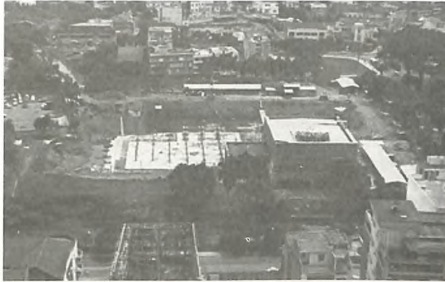
Figura 79. Centro Administrativo Municipal (CAM) en construcción, sobre el predio ocupado por el Batallón Pichincha (ca. 1970).
