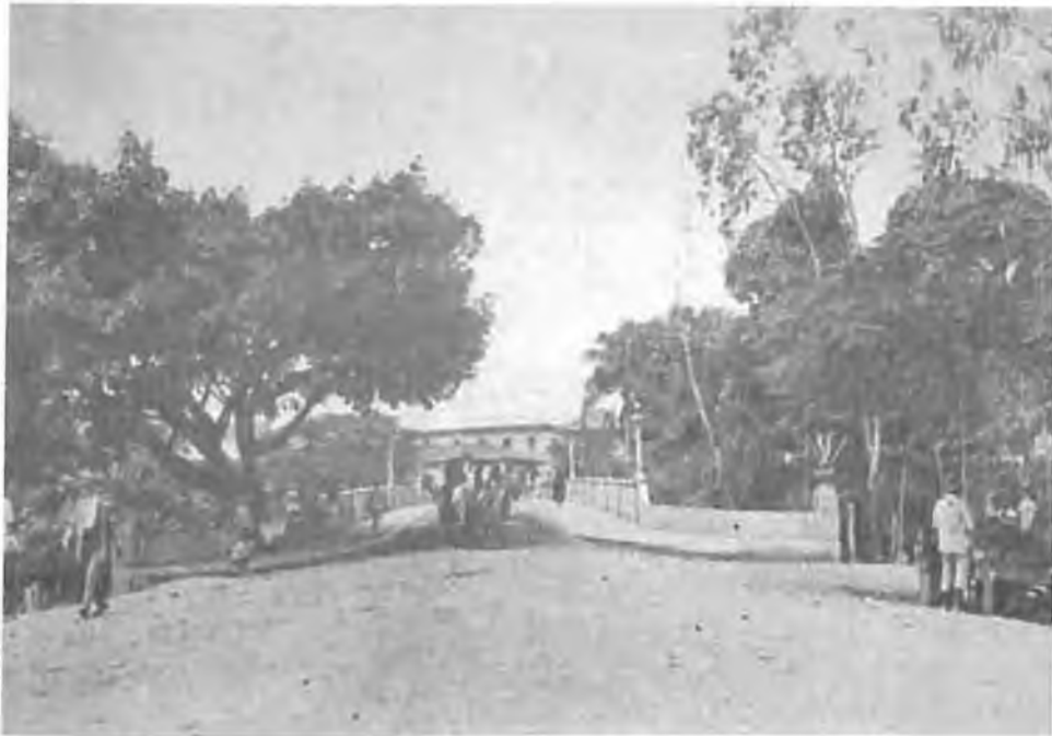
Figura 16. Vista del puente Ortiz de norte a sur.
