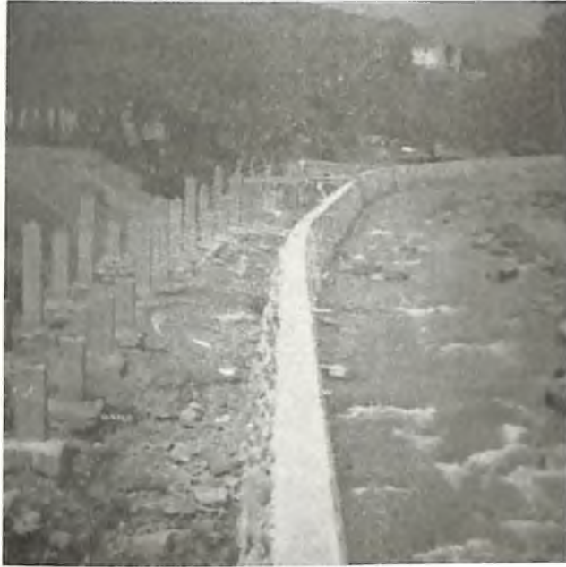
Figura 65. Muros de contención junto al río Cali en fase de ejecución; también se aprecian las columnas de hormigón que servirían de soporte a la calzada, asociados al relleno artificial bajo la avenida Colombia. Fuente: Otero (1944).
