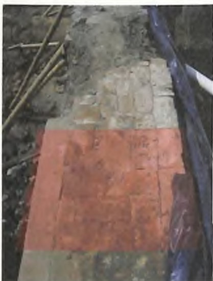
Figura 27. Aparejos de ladrillo en el muro este del puente sobre el río Cali.
