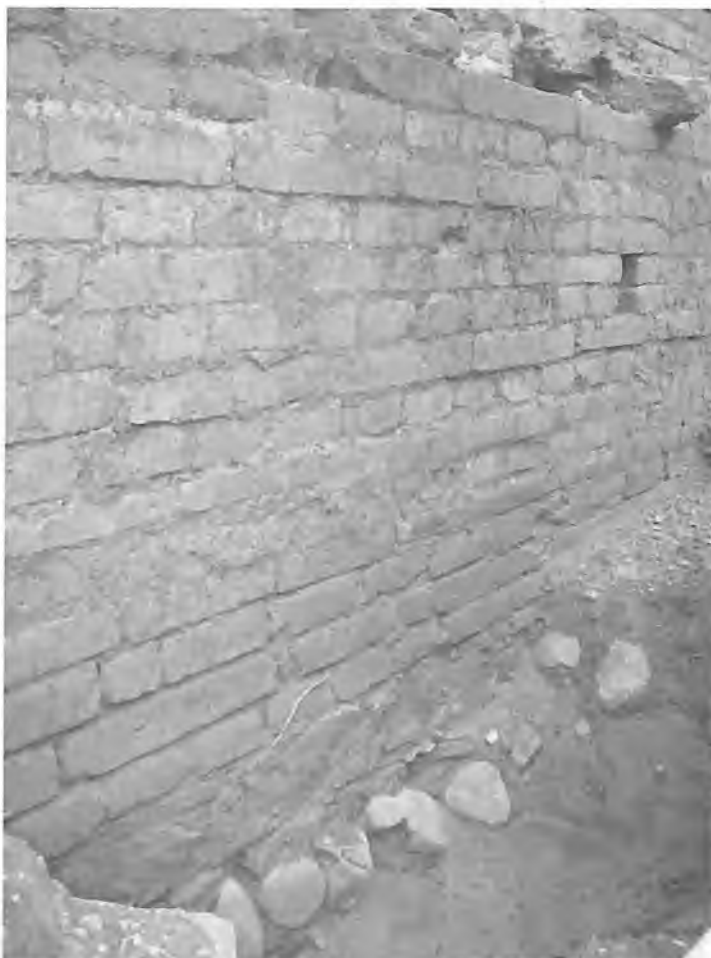
Figura 11. Detalle de la cimentación de uno de los muros pertenecientes al estribo sur del puente de calicanto.
