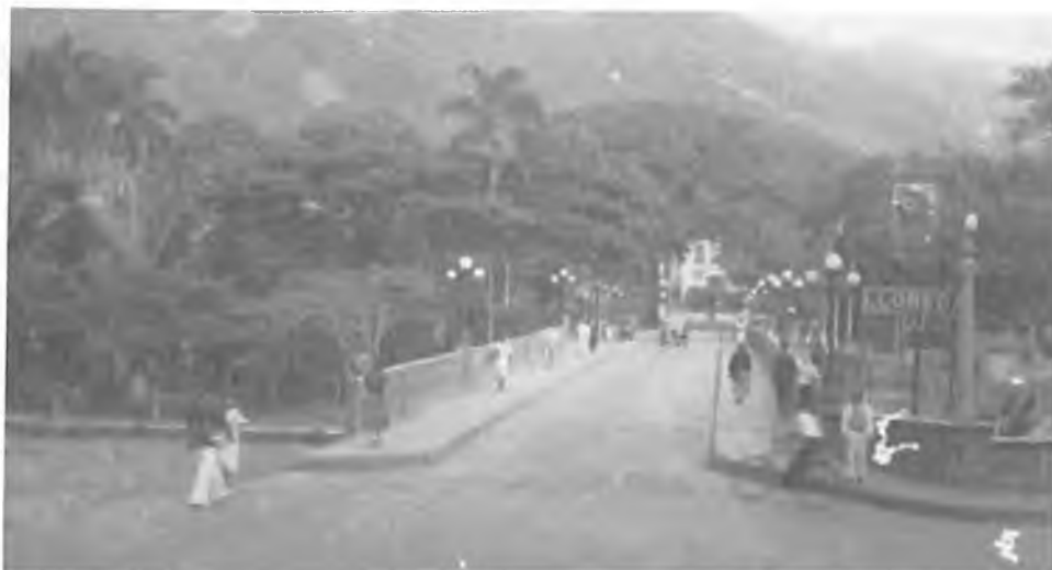
Figura 52. Extremo sur del puente luego de la demolición de la casa de los señores Giraldo y Garcés (1919) que estaba al lado derecho de la foto.
