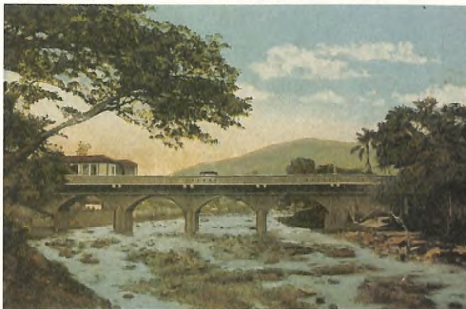
Figura 41. Vista lateral del puente sobre el río Cali luego de la ampliación del ancho de la calzada, en 1918
