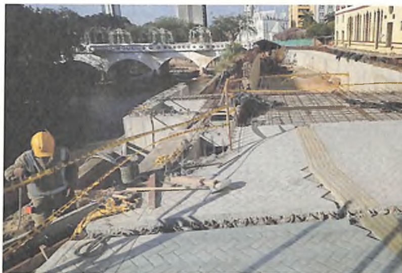
Figura 82. Vista de la avenida Colombia al término de las obras civiles a cargo de Conalvías (2012).
