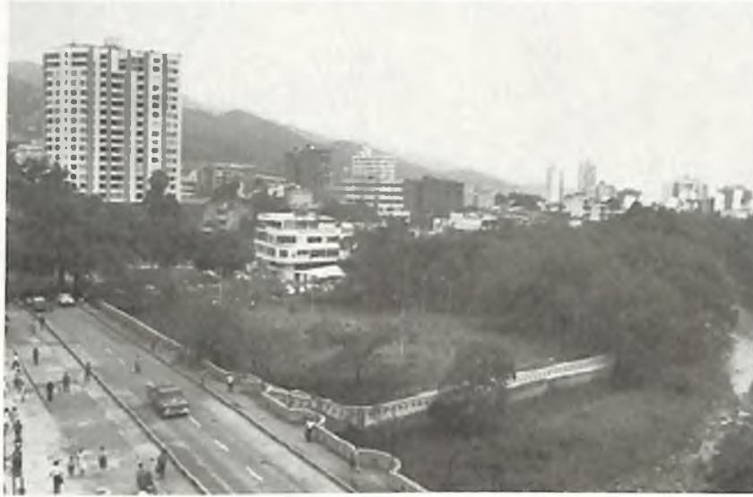
Figura 77. Vacío urbano producido por la ausencia del edificio Gutiérrez Vélez. Al fondo, los edificios de la Manzana T. Fotografía: Jaime Vásquez.
