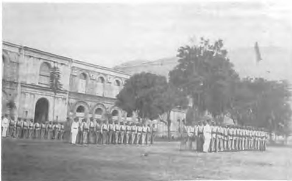
Figura 43. Fachada principal del edificio del Cuartel en torno a 1927, en proceso de construcción.
