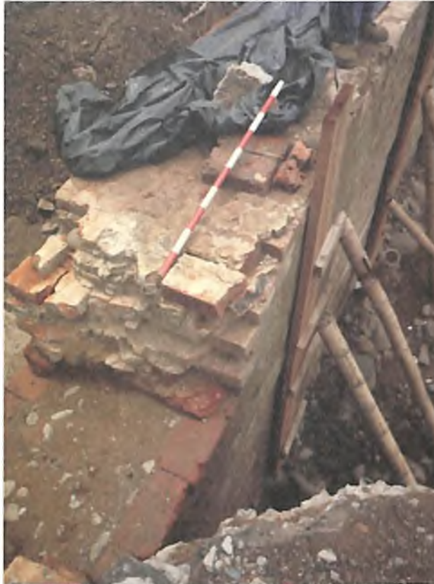
Figura 26. Vista del muro del muro que mira aguas arriba del río Cali. Nótese el núcleo de argamasa y los dos revestimientos laterales de albañilería.
