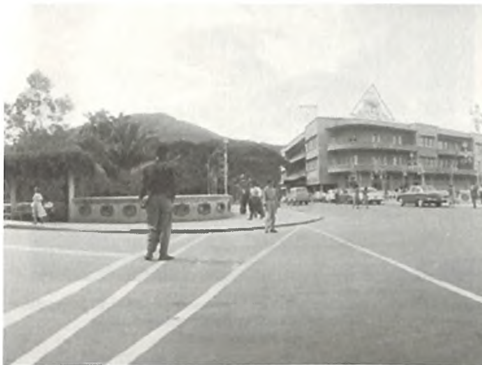
Figura 76. Unidad formal del pavimento del puente Ortiz y sus áreas aledañas en 1960.
