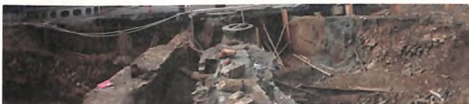
Figura 81. Area de excavación correspondiente a los muros que hicieron parte del estribo sur del puente Ortiz.
