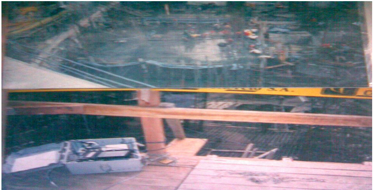
Figura 1. Detalle datalogger para monitoreo térmico del concreto en la Placa macisa de cimentación, Parque Central Bavaria
