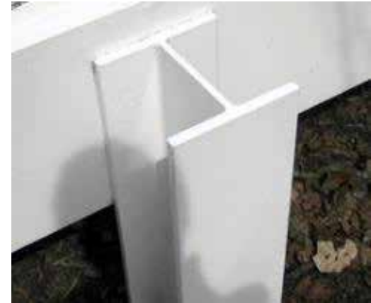
Detalle unión viga-columna casa Fansworth. Img. 98
