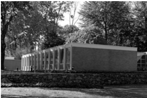
Casa Morris. Img. 62
