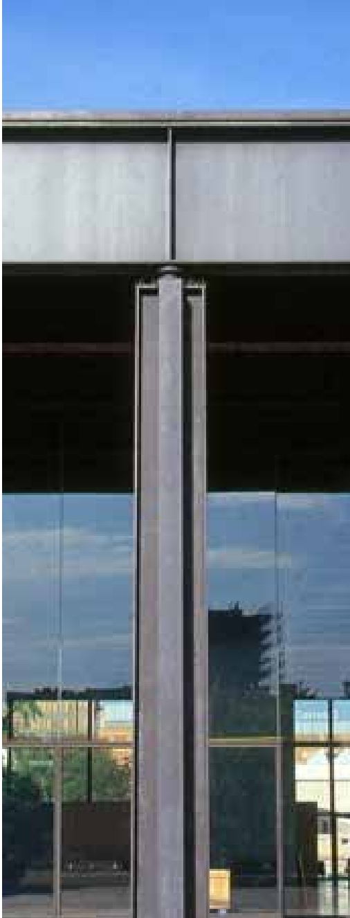
Img. 73 Detalle unión columna-viga Galería Nacional de Berlín
