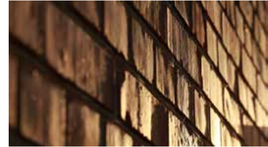
Detalle pared en mampostería casa Lemke. Img. 138
