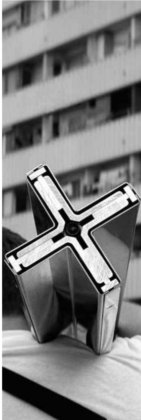
Sección columna pabellón de Barcelona Img. 151
