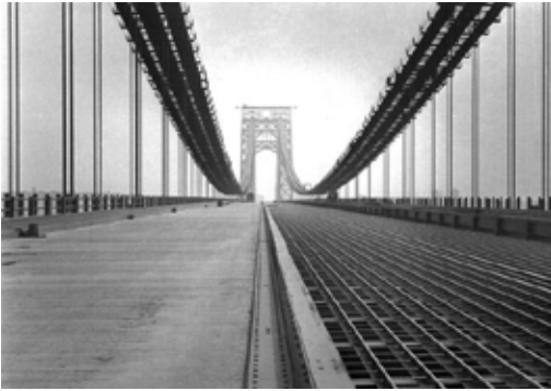
Puente George Washington en construcción Nueva York. Img. 76
