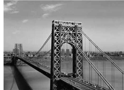
Puente George Washington NY. Img. 74
