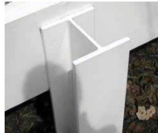
Detalle unión viga-columna casa Fansworth. Img. 78
