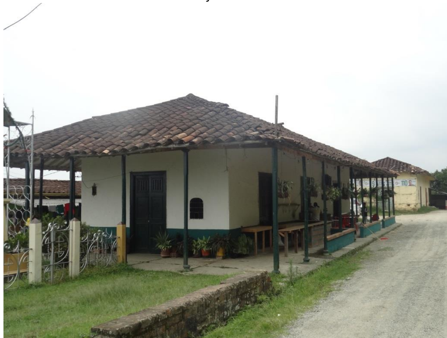
Gráfico 10 Vista del conjunto de la Estación
