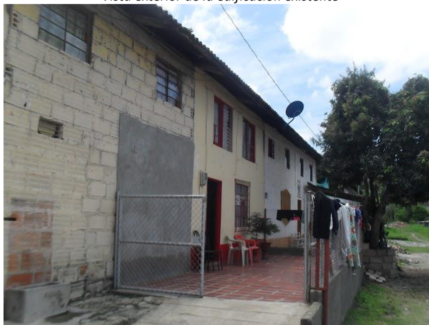
Gráfico 7 Vista exterior de la edificación existente
