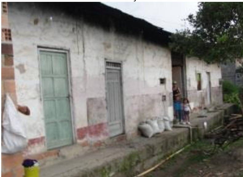
Gráfico 4 Vista exterior de la edificación existente
