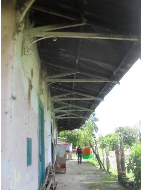
Gráfico 6 Vista exterior de la edificación existente
