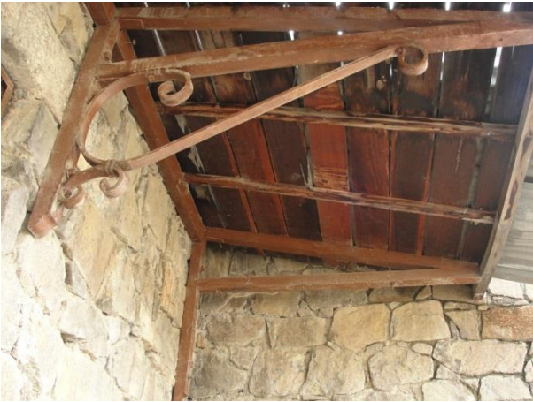
Detalle de pie amigos de cubierta
