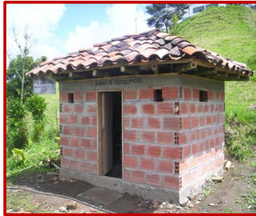
Figura 8: Bodega para el almacenamiento de agroquímicos de forma segura, para evitar accidentes.
