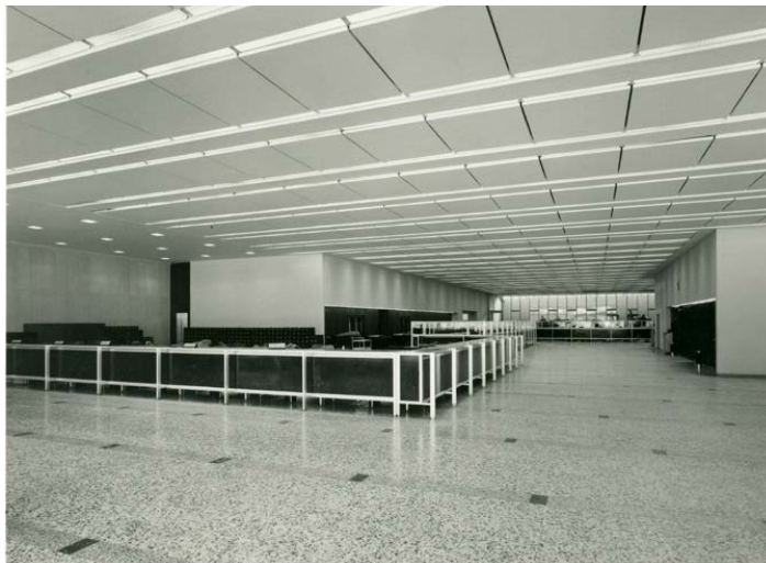
Fig. 75. Interior primer piso Edificio BCH.
