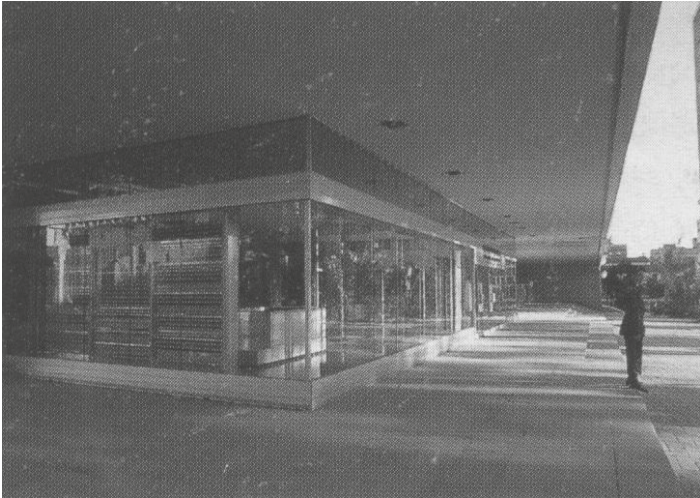
Fig. 11. Vista al acceso del museo bajo el voladizo y de la continuidad del espacio.
