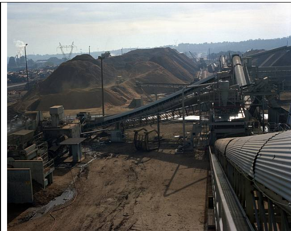
Fig.8 Shasta Energy Company, Anderson, California. Producción de 49-MWe en ciclo Rankine a partir de combustión de madera y pulpa de papel. (Fotografía NREL).
