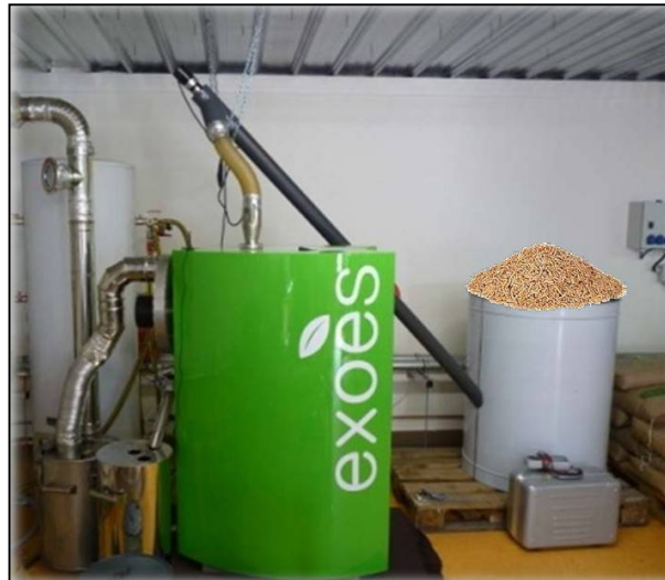
Fig.14. Unidad doméstica de micro cogeneración EXOES a ciclo de Rankine a partir de gránulos de madera, produciendo 1.6 kWe y 16kWth.
