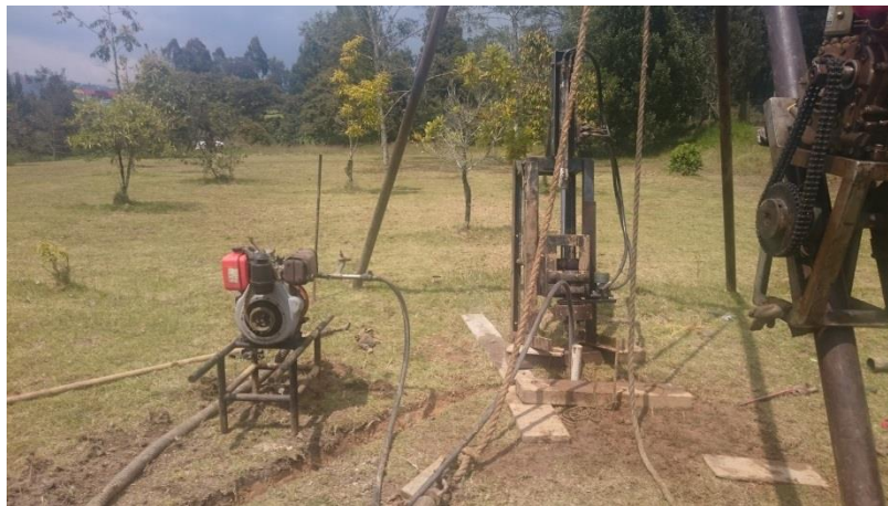
Fotografía 5. Localización aproximada de la perforación ejecutada en el sitio de estudio II
