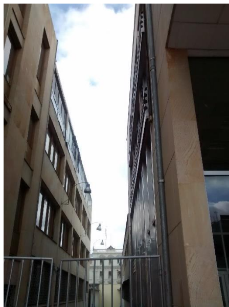
Figura 26. Fachada principal de la Gobernación de Nariño por la calle 19
