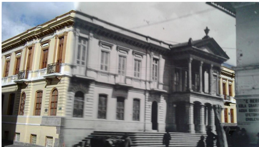
Figura 32. Pasado y Presente: Fotografía 4 Fachada de la Gobernación de Nariño
