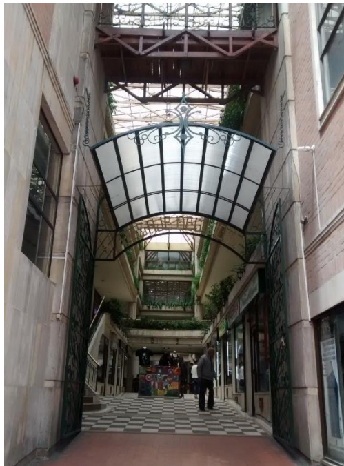
Figura 5. Fachada principal pasaje el Liceo
