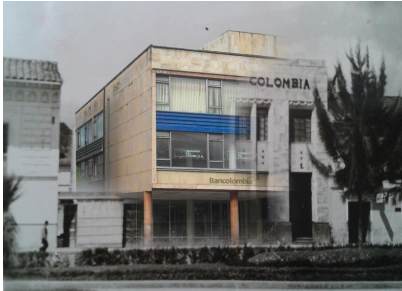
Figura 34. Pasado y Presente: Fachada Banco de Colombia
