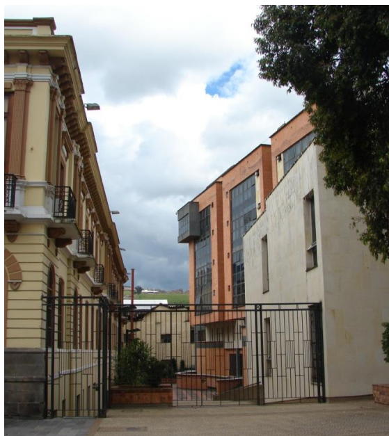
Figura 17. Fachada principal de la Gobernación de Nariño por la calle 19
