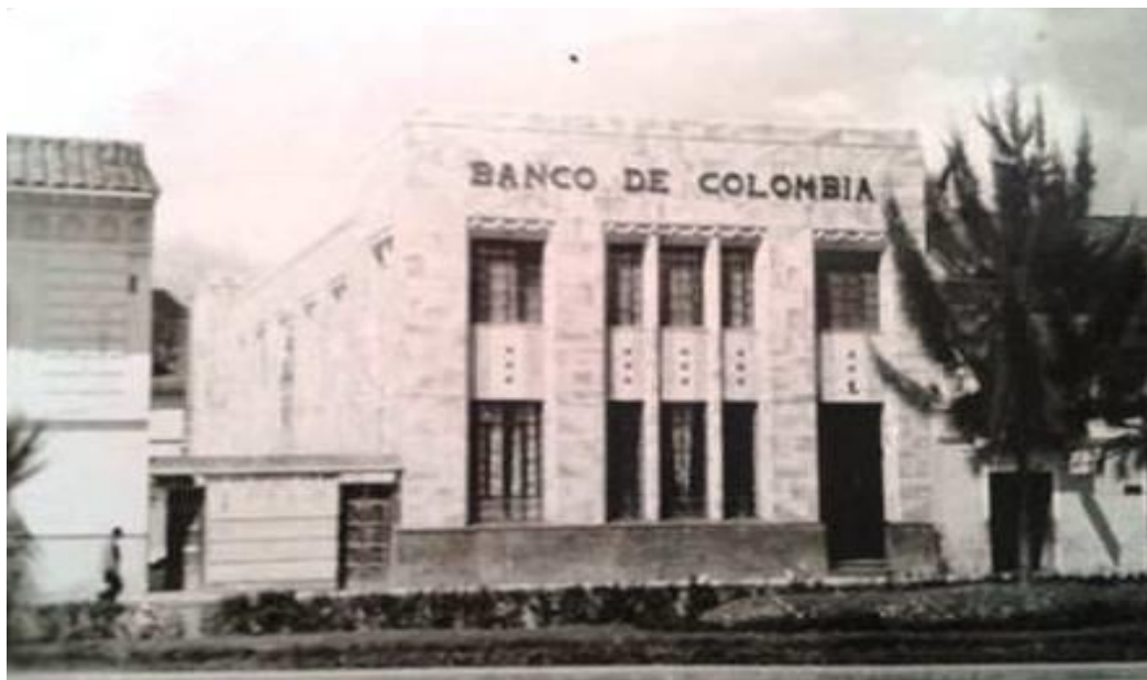
Figura 27. Fachada principal del Banco de Colombia
