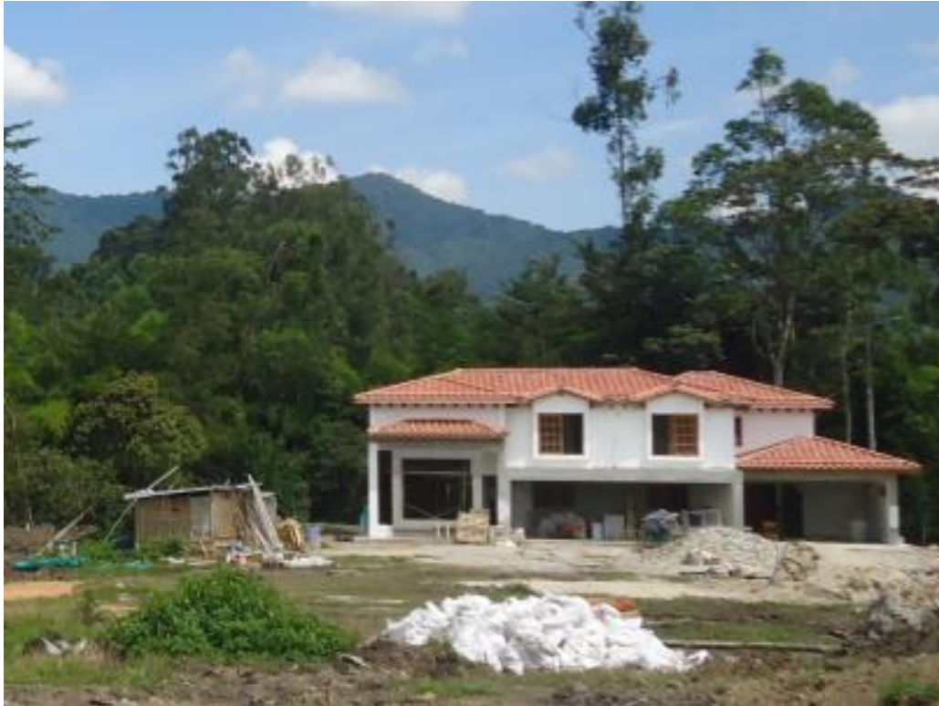
Casa Campestre en construcción Vereda Aguas Claras
