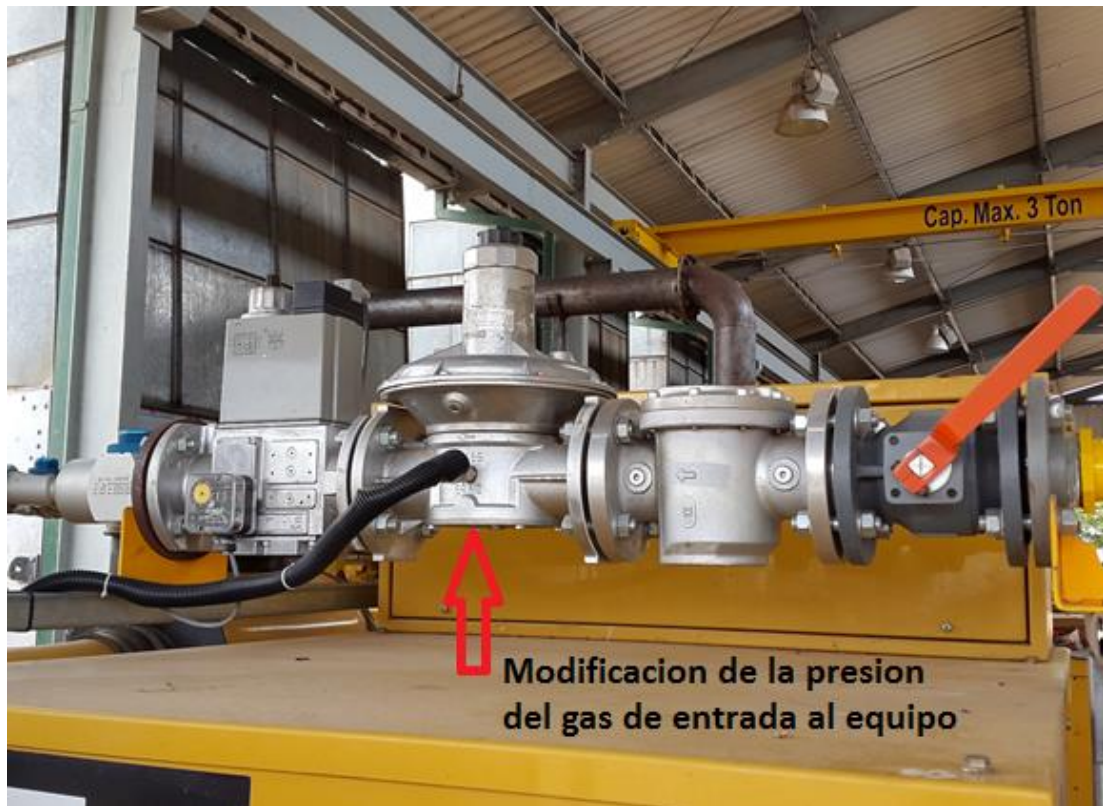
Fotografía 8: Detalle del sistema dual-fuel (entrada gas al motor)
