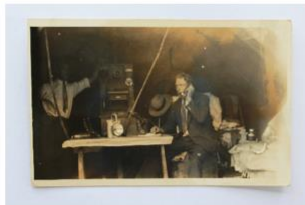
Manchas deterioro químico
