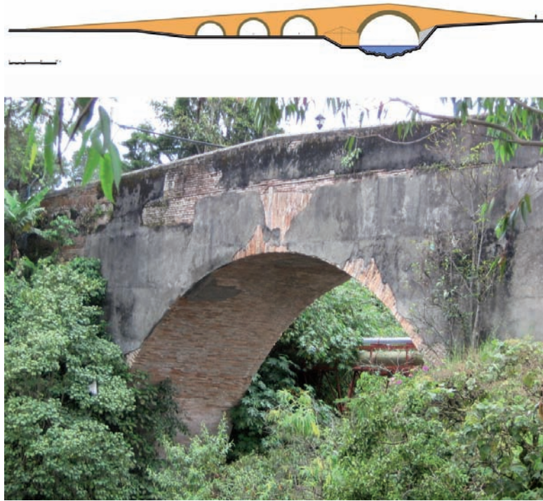
Figura 2.3 Alzada y fotografía reciente del puente sobre el río Cauca, en Popayán (c.a. 1769). Fuente: Elaboración propia.
