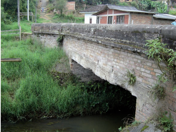
Figura 3.27 Puente sobre la quebrada de Chambio (1927). Foto: J. Galindo (2006).
