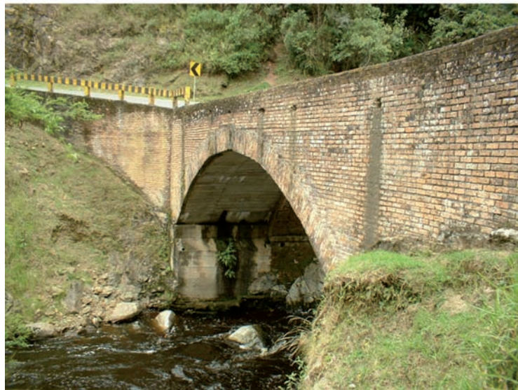
Figura 2.17 Alzada y fotografía reciente del puente sobre el río Cauca en inmediaciones de Coconuco (1907). Fuente. Elaboración propia.
