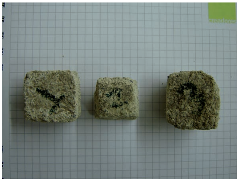
Figura 4.12 Muestras de los especímenes de mortero obtenidos del puente de Quilcacé. Foto: M. Caicedo (2007).
