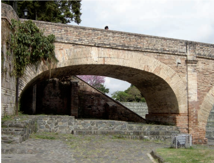
Figura 3.10 Arco carpanel en el puente del Humilladero sobre el río Chiquito, en Popayán (1868).
