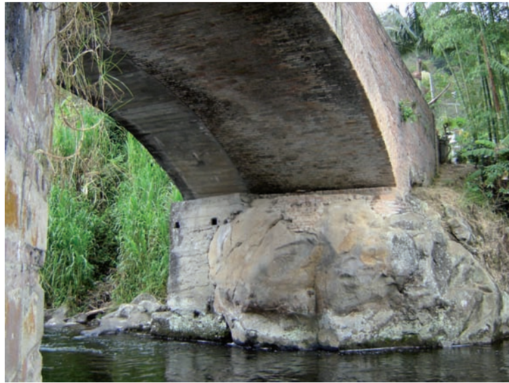
Figura 3.5 Cimiento natural en el estribo izquierdo del puente sobre el río Piendamó (1892). Foto: J. Galindo (2007).
