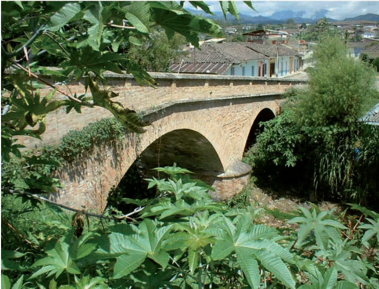
Figura 3.7 Puente sobre el río Timbío en la población del mismo nombre (s.f.). Foto: J.C. Guzmán (2007).
