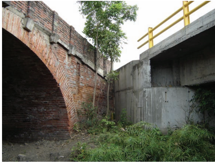
Figura 3.25 Puente sobre la quebrada Popurrinas, en el camino entre Palmira y Buga (1891). Foto: J. Galindo (2007).
