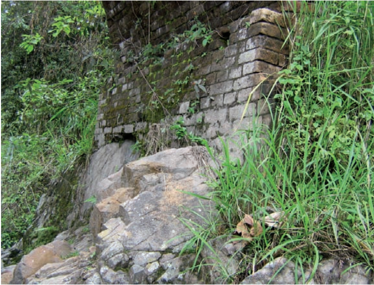
Figura 3.4 Cimiento natural de uno de los estribos del puente sobre el río Quilcacé (s.f.).
