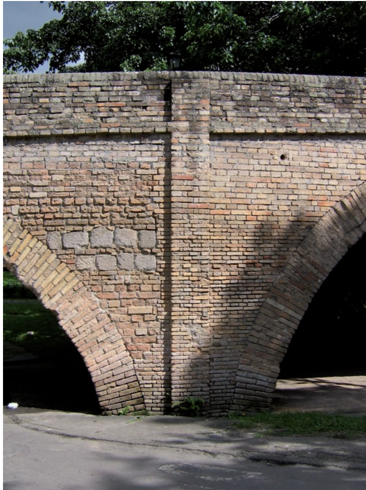
Figura 3.24 Detalle del refuerzo ornamental en el puente del Humilladero, en Popayán (1868). Foto: J. A. Paredes (2007).
