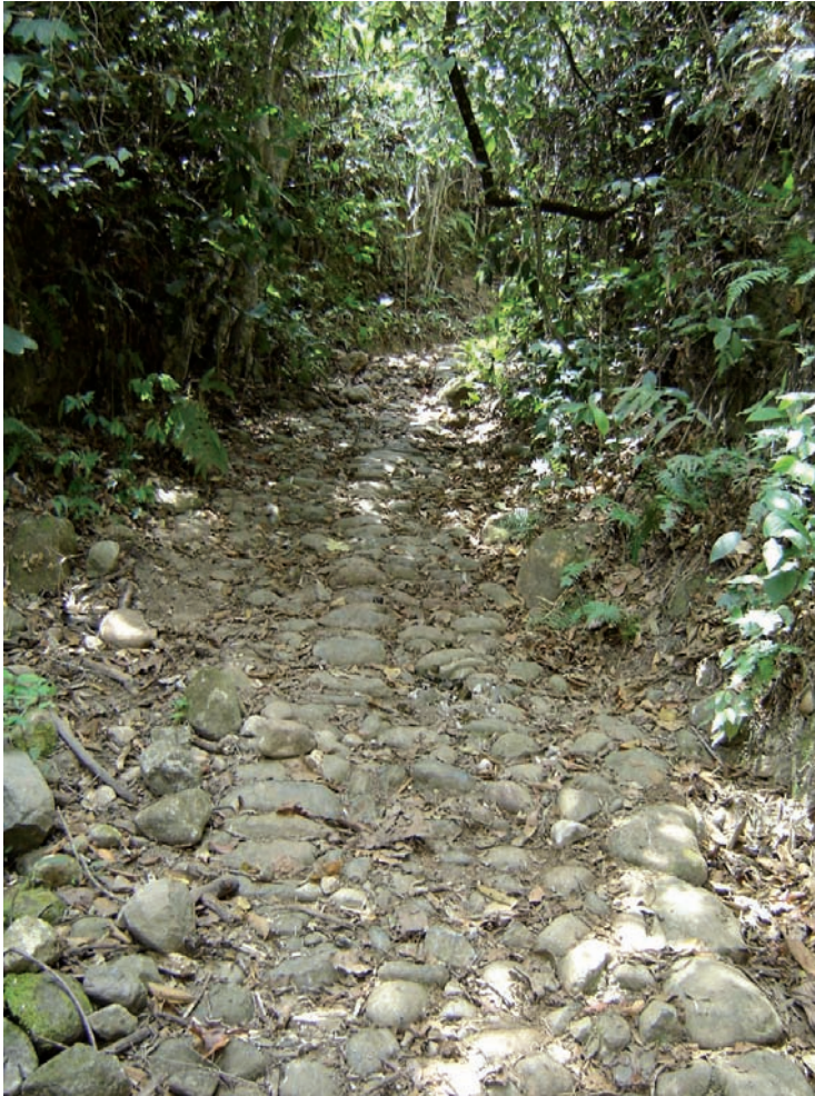
Figura 3.26 Empedrado existente en el camino que desciende al puente sobre el río Ovejas.
