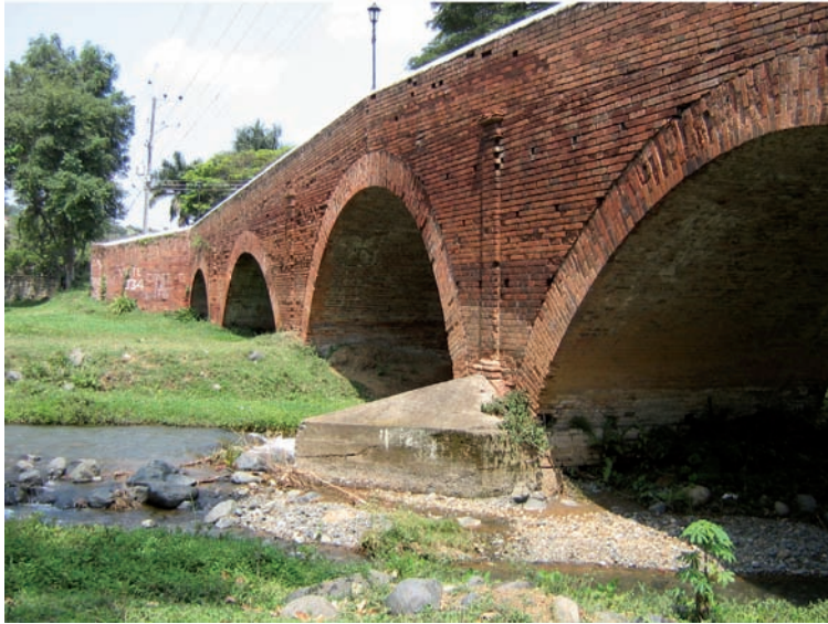
Figura 2.16 Alzada y fotografía reciente del puente sobre el río Grande en la población de Caloto (1903). Fuente. Elaboración propia.
