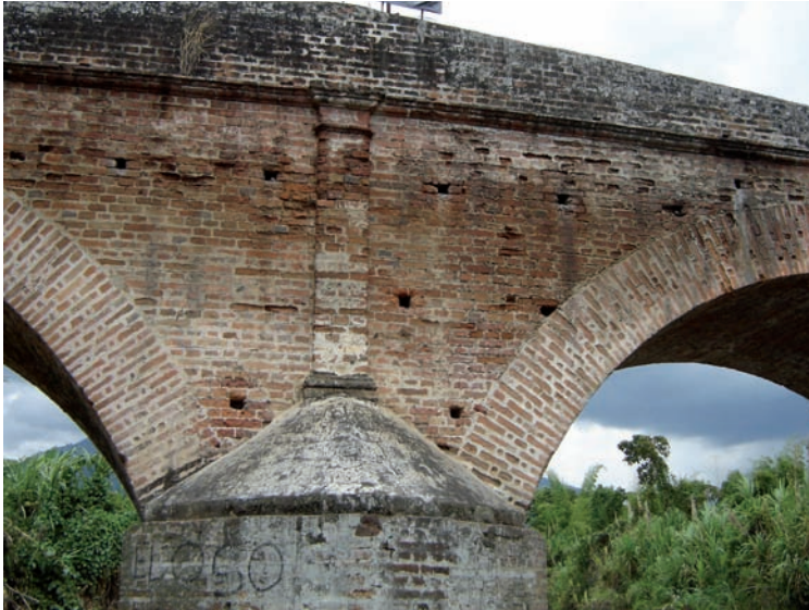
Figura 3.22 Huellas de andamios laterales en el puente sobre el río Güengüé (1890). Foto: J. Galindo (2006).
