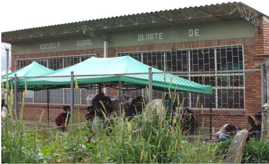
2. Fachada de la institución.
