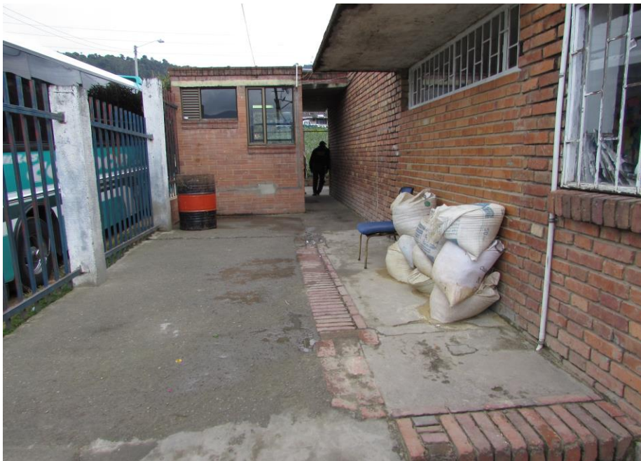
3. vista opuesta del corredor secundario
