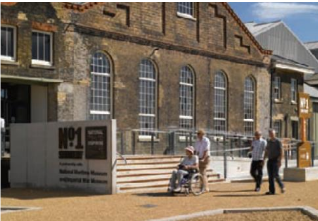
Fuente. English Heritage(2012, p. 20) Edf. Chatham Historic Dockyard [Reino Unido]
