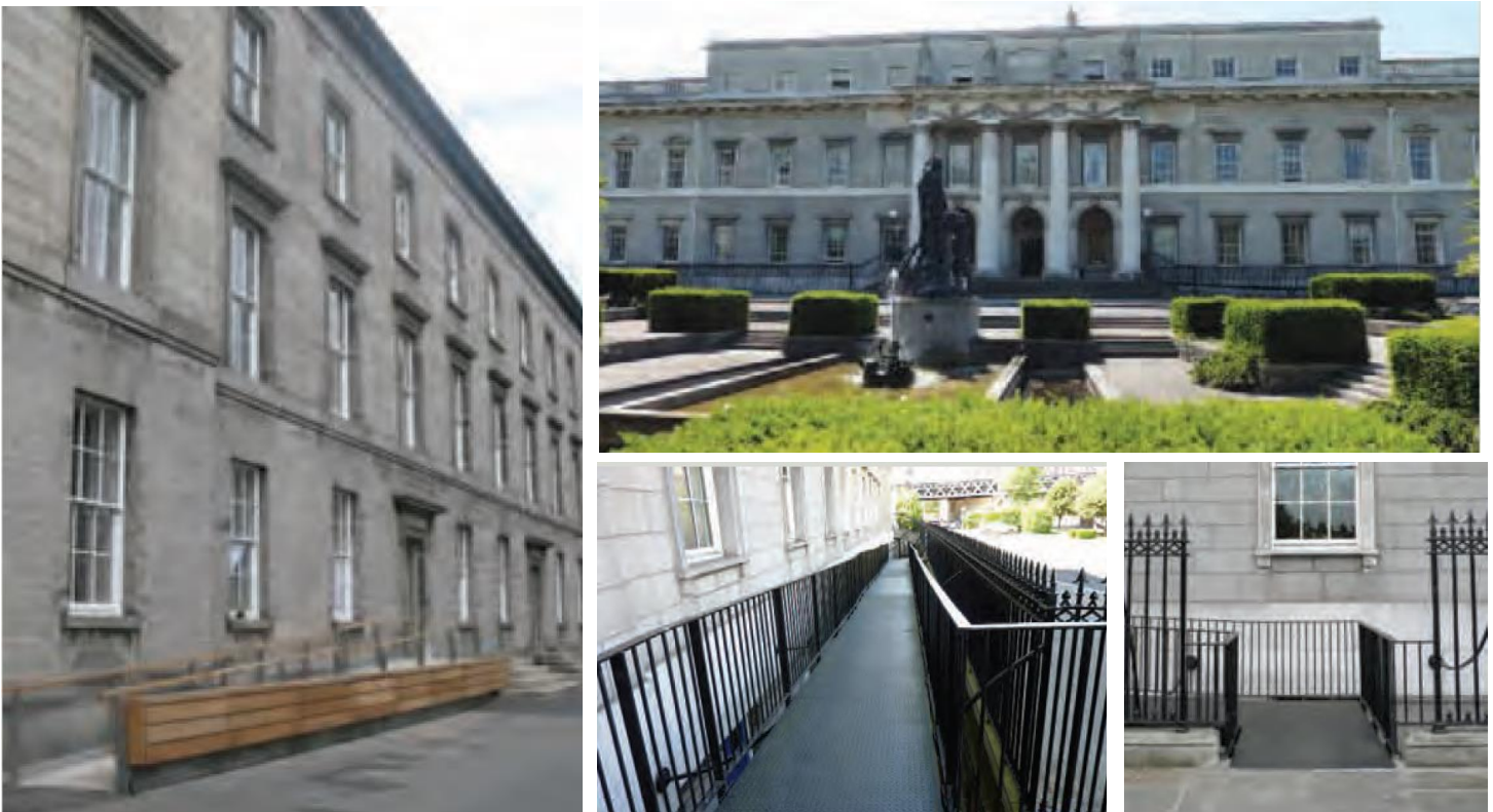
Imagen 12. Rampas en el acceso principal
