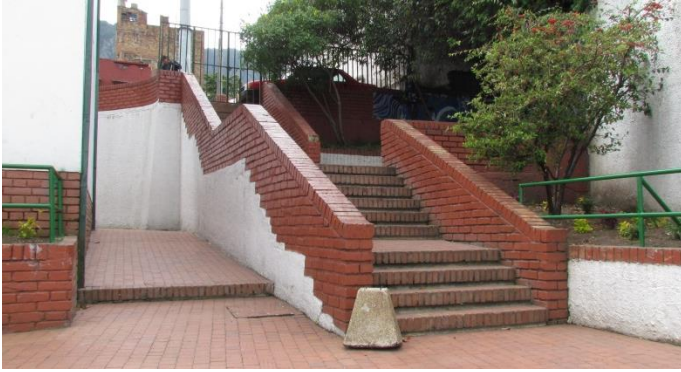
Terraza de acceso a parqueaderos
