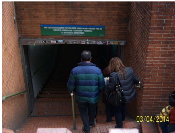
Foto 1-2: Cruces de peatonales deprimido
