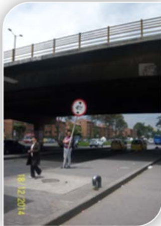
Señales verticales en mal estado, y no hay presencia de señalización horizontal
