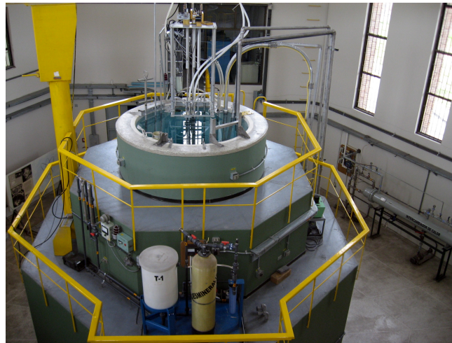
Figura 3-5.: Reactor Nuclear IAN-R1 (foto tomada por José Alberto Gómez).
