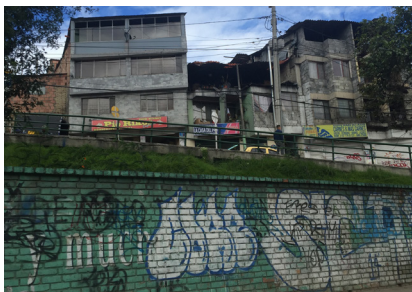
VIVIENDAS EN RIESGO
