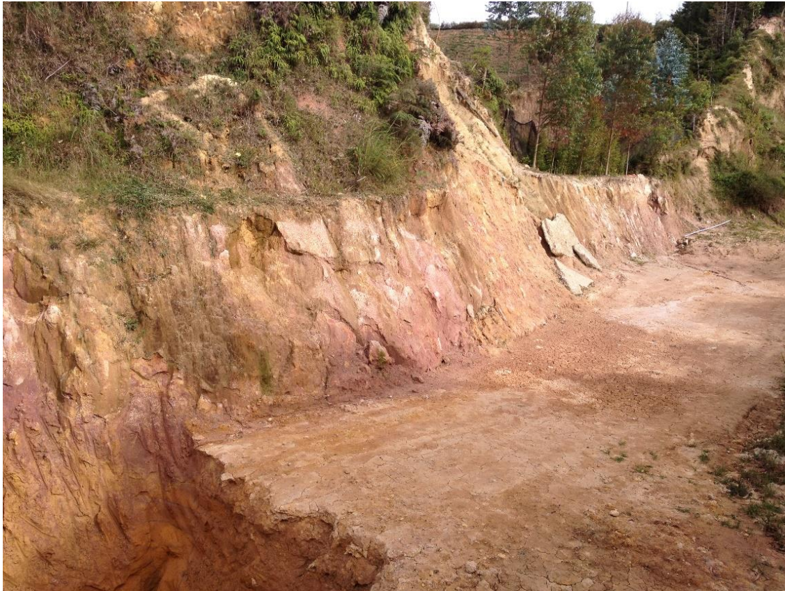
Fotografía 4-3: Zona de recuperación de la muestra natural inalterada.
