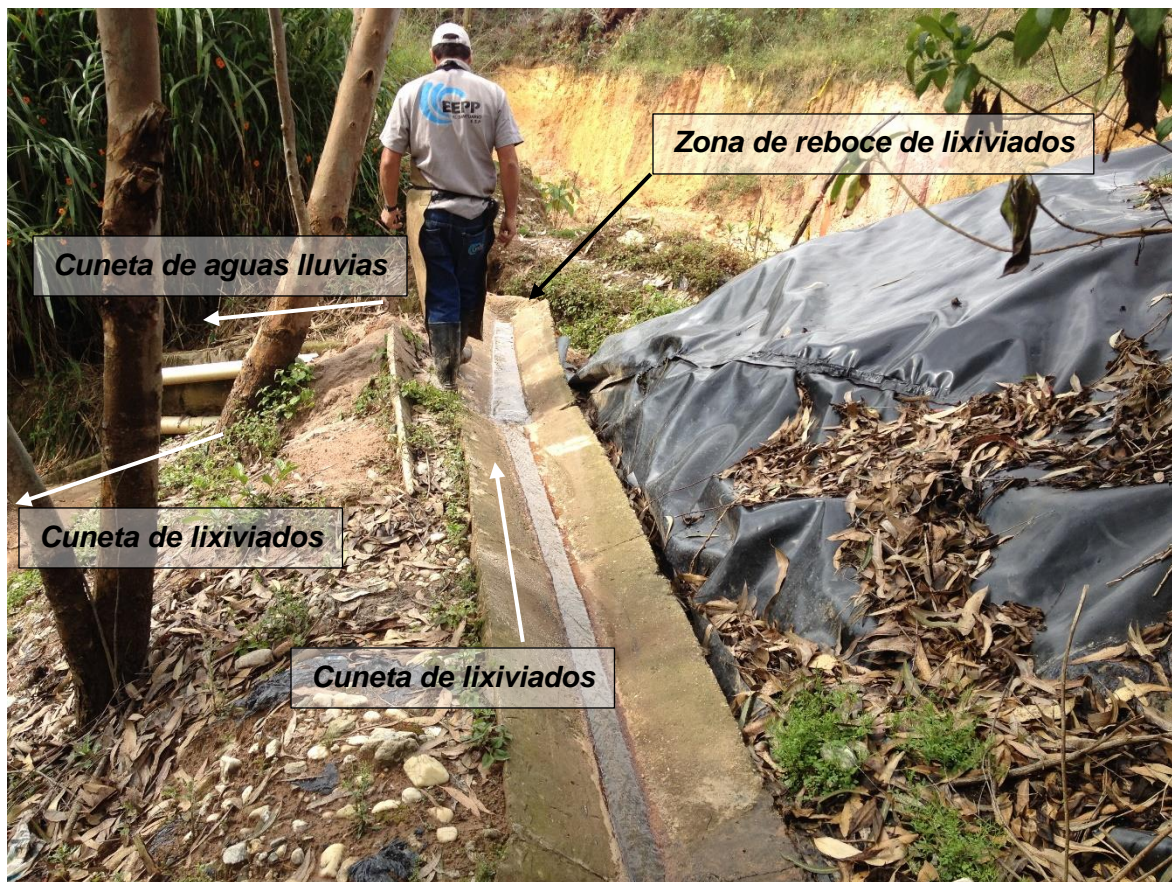
Fotografía 4-5: Zona de paso de lixiviados a cunetas de aguas lluvias
