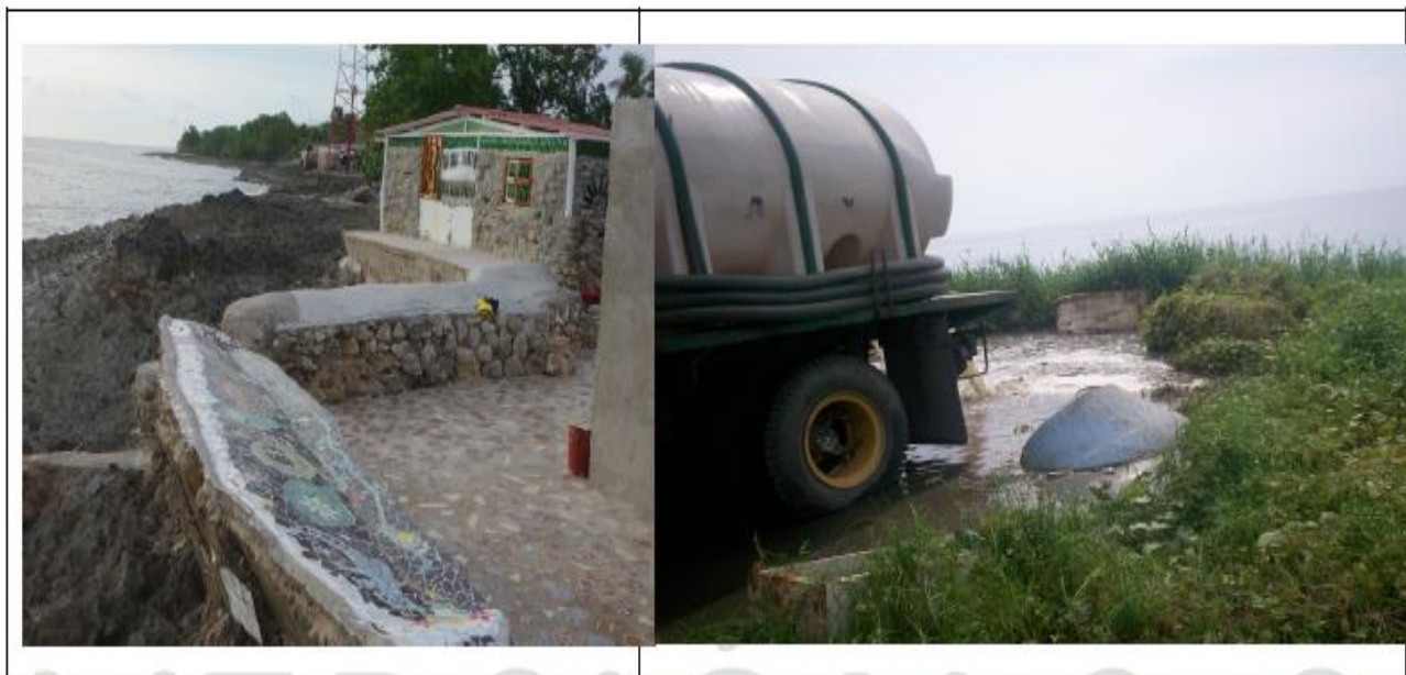
Figura 21. Transformación del litoral rocoso para actividades comerciales y vertimientos de aguas residuales directamente sobre el borde litoral
