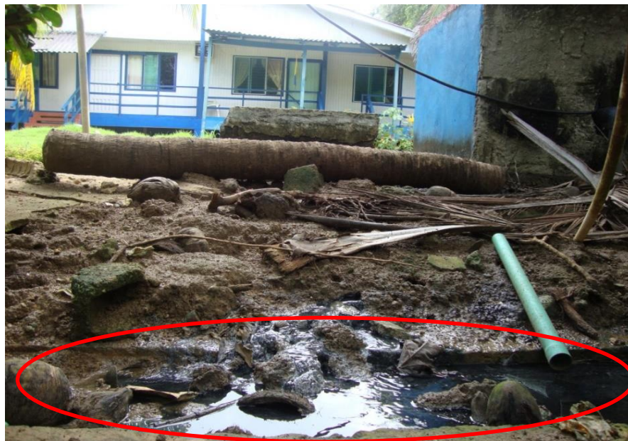
Figura 16. Aguas residuales brotando de un pozo séptico comunitario de un barrio de suboficiales de la armada nacional el cual queda dentro de la Cuenca del Cove.
