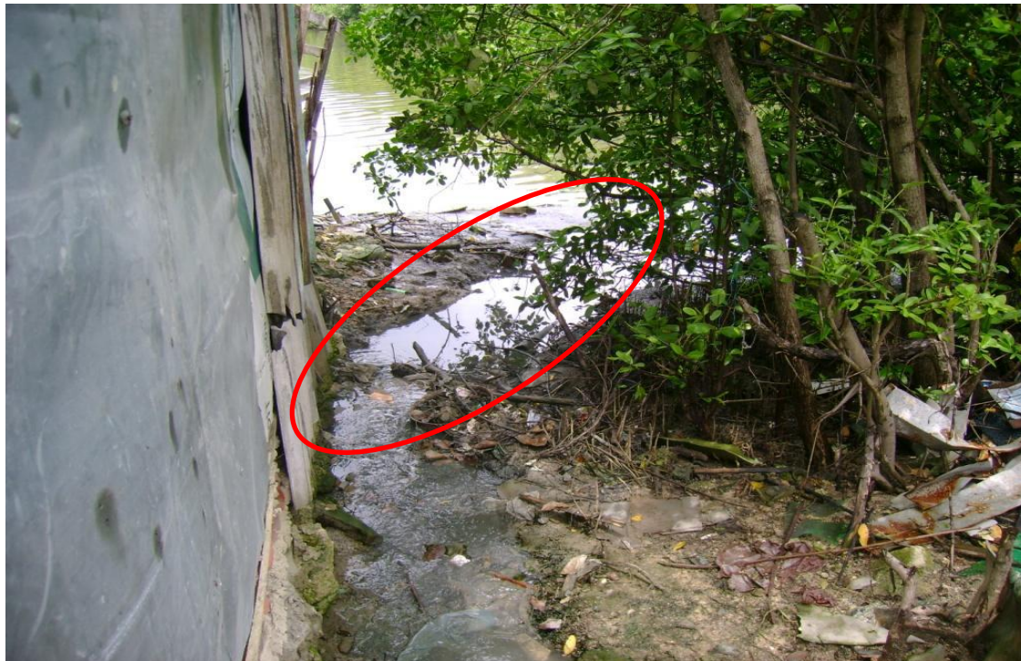
Figura 3. Aguas residuales provenientes del barrio El Obrero vertiéndose en el parque regional Old Point
