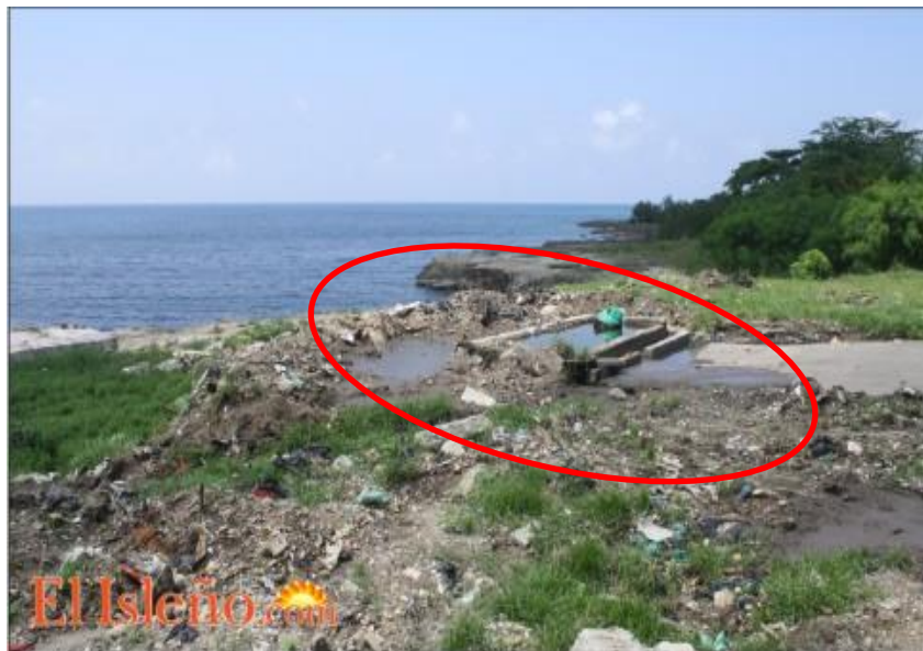
Figura 17. Vertimiento de aguas residuales directas al mar generadas por los pozos sépticos (km 3 en la vía circunvalar)
