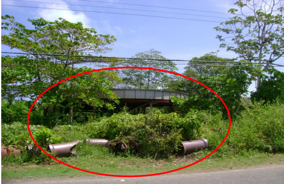
Figura 13. Planta de tratamiento de aguas residuales abandonada
