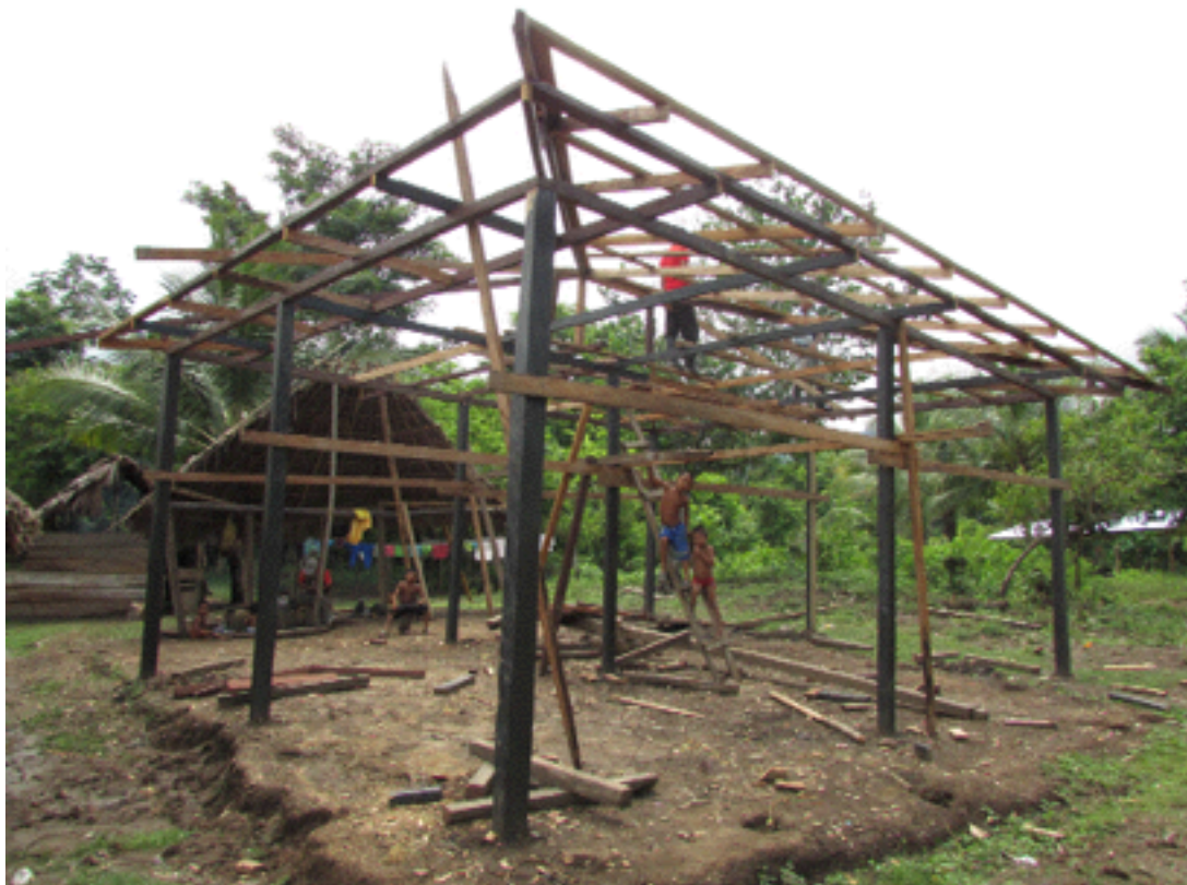
Figura 21. Construcción de una casa familiar, resguardo de Makilakuntiwala (Arquíá). Fuente: foto autor.
