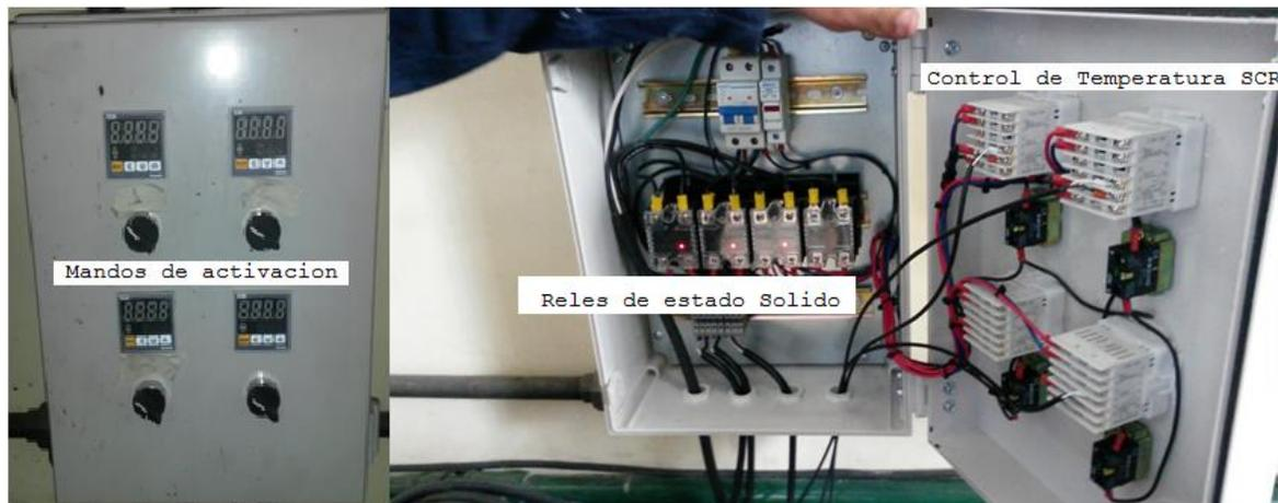
Figura 26: Sistema de control de temperatura para ducto salida de gases.
