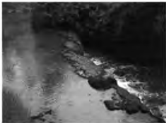
Fotografía 15. Río Teusacá kilómetro 5+980. Piscina antecedente a caída natural de 1.5 m de altura en promedio.
