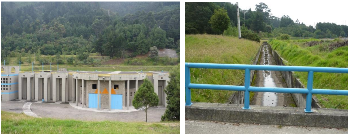
Figura 65. Tanques del silencio. Estructura de control y tanque de almacenamiento, Calle 33 con Avenida Circunvalar
