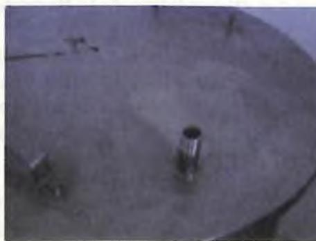
Válvula faltante tanque desgasificador
