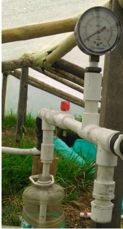
Figura 5-45. Válvula de seguridad, manómetro y “te” para liberación de agua acumulada en la tubería
