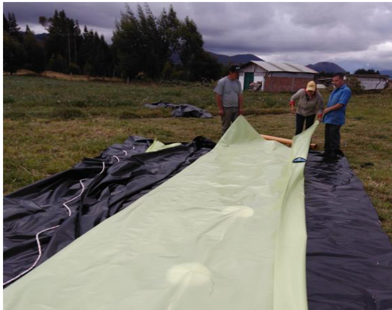
Figura 5-40. Plástico con salida de biogás y mezclador instalados
