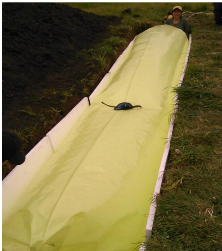
Figura 5-43. Inflado y organización del biodigestor en la zanja
