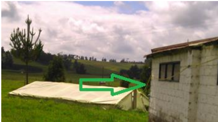
Figura 5-46 Tubería de conducción de biogás hasta el reservorio
