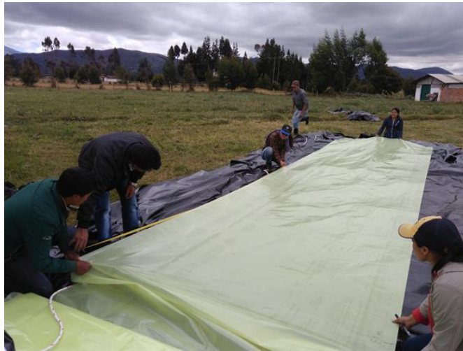
Figura 5-38. Cortado del plástico tubular para la construcción de los biodigestores.
