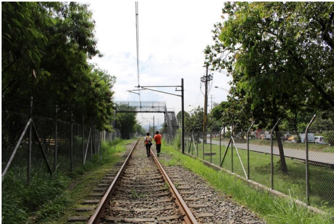
Figura 11. Fotografía del lugar desde el viaducto de tren
