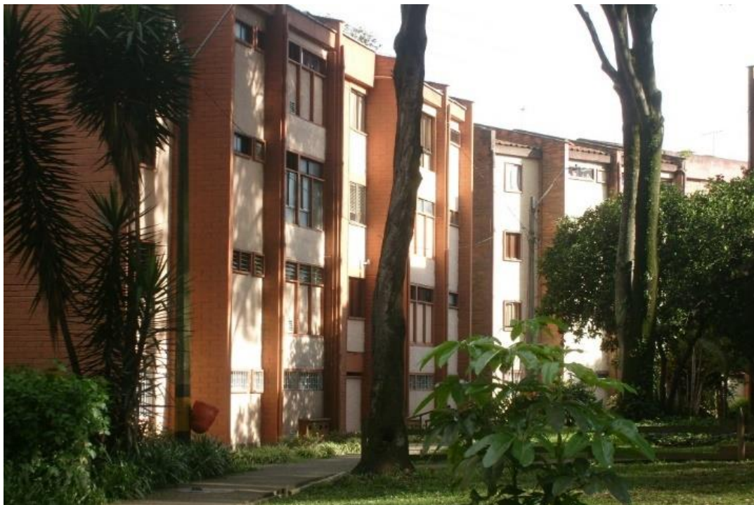
Figura 52 Edificios Carlos E. Restrepo.
