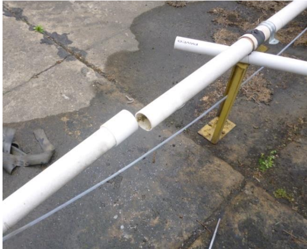
Figura 3-6: Reparación de fuga en Tubería de 2".
