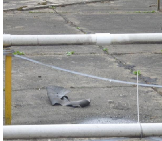
Figura 3-7: Reparación de fuga en Tubería de 2".
