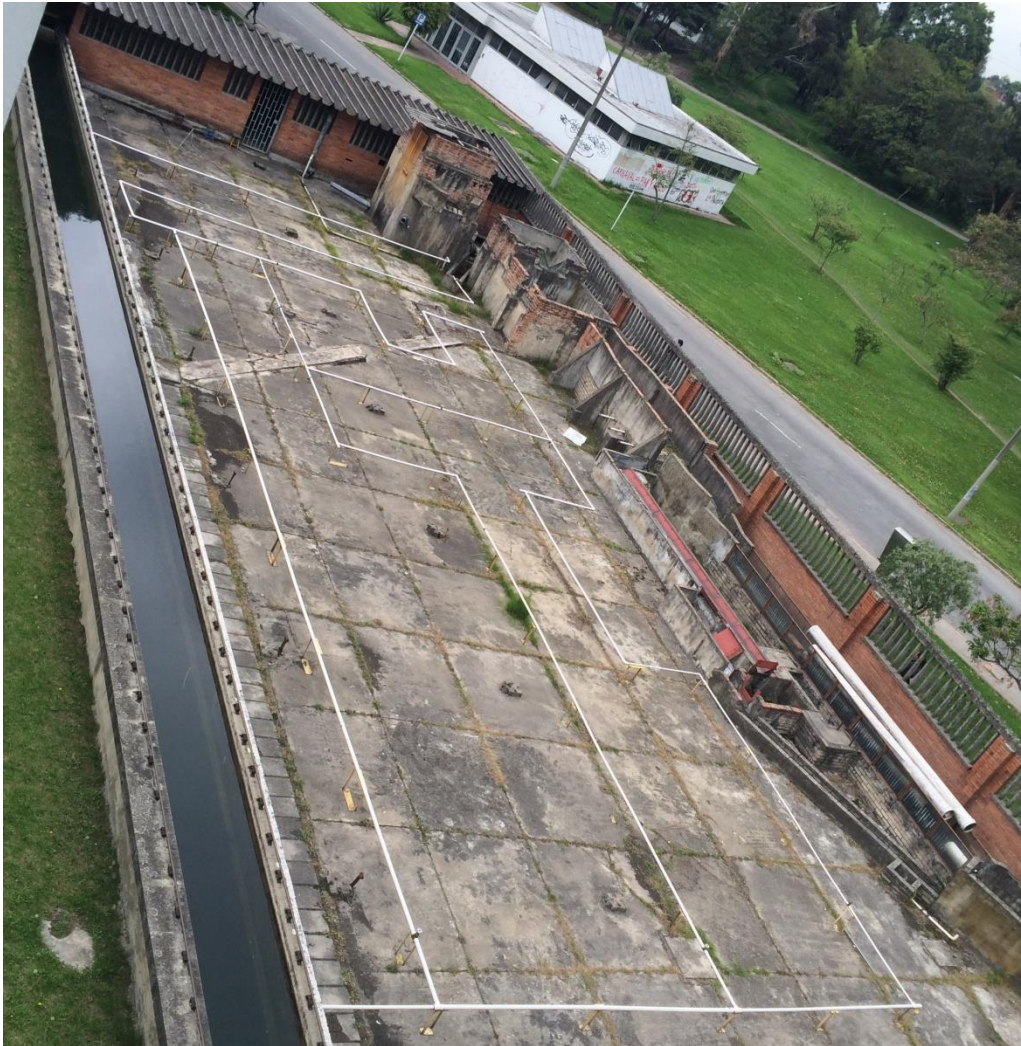
Figura 3-1: Instalación física red de agua a presión utilizada.
