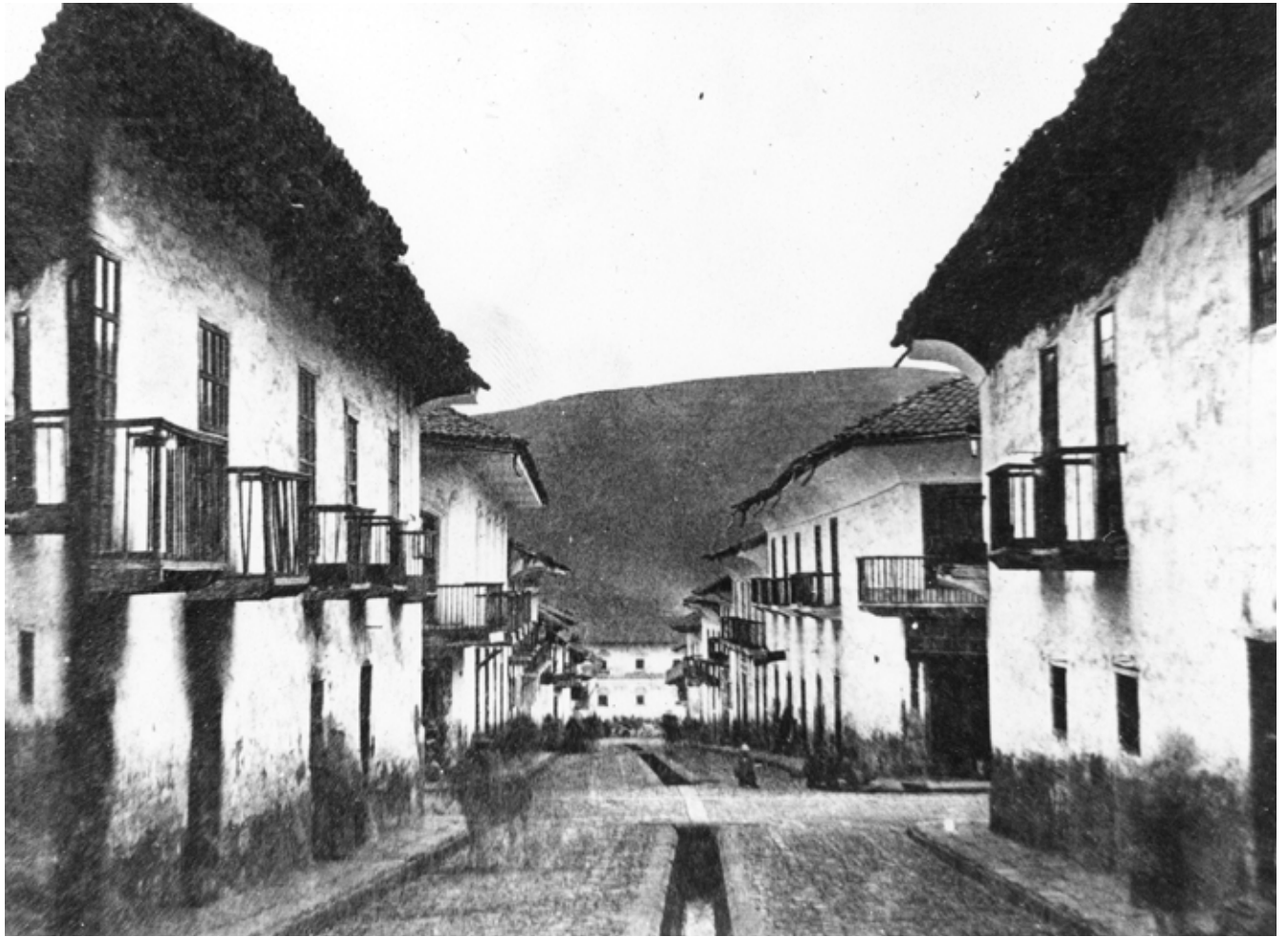
Gráfico 68. Calles con zanja para desalajo de aguas servidas Fuente: Fondo fotográfico del Ministerio de Cultura de Ecuador
